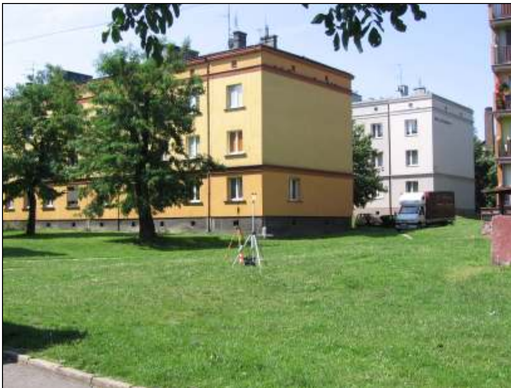
Fot.1. Rejon badań, widok w kierunku południowo-zachodnim
