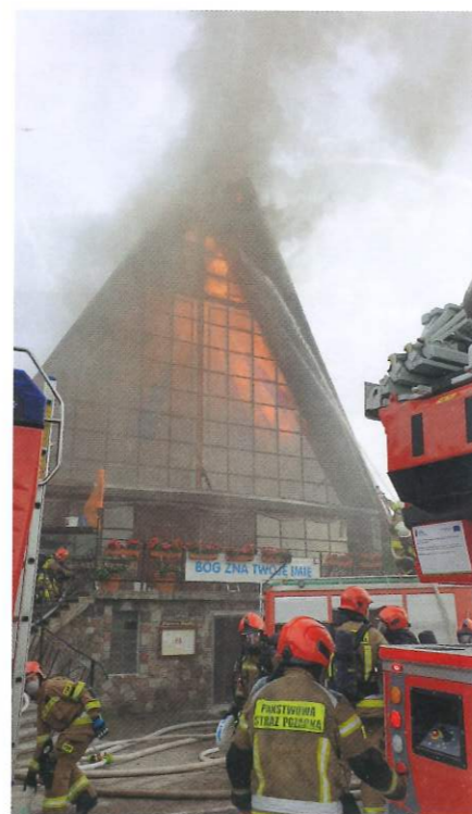
Żywioł opanował budynek świątyni fot. Piotr Woliński / KM PSP w Elblągu
