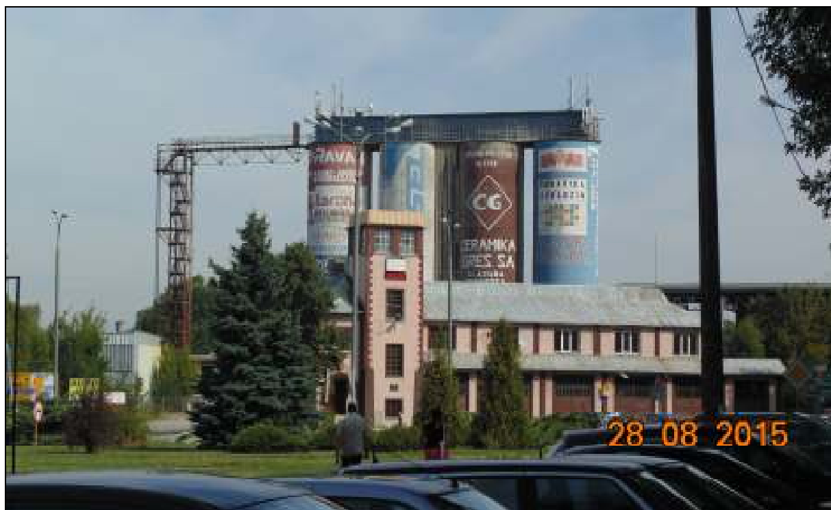
Fot.3. Lokalizacja instalacji radiokomunikacyjnych
