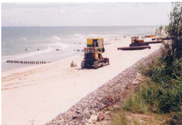
Rys. 5.13. Odbudowa zniszczonego brzegu poprzez sztuczne zasilanie piaskiem
