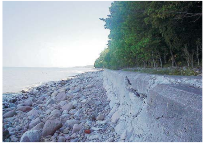
Rys. 10.40. Betonowa opaska brzegowa w Rozewiu
