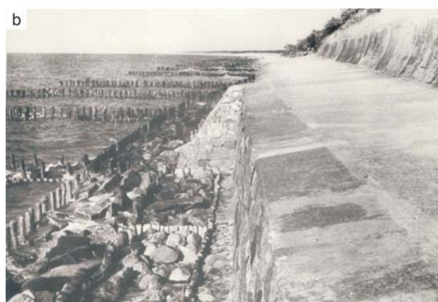
Rys. 5.6. Opaski brzegowe w okolicy Ustronia Morskiego (a) oraz Niechorza (b)
