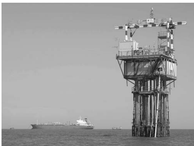
Rys. 4.26. Bezzałogowa platforma głowicowa PG-1 pracująca na złożu B-3 na Morzu Bałtyckim
