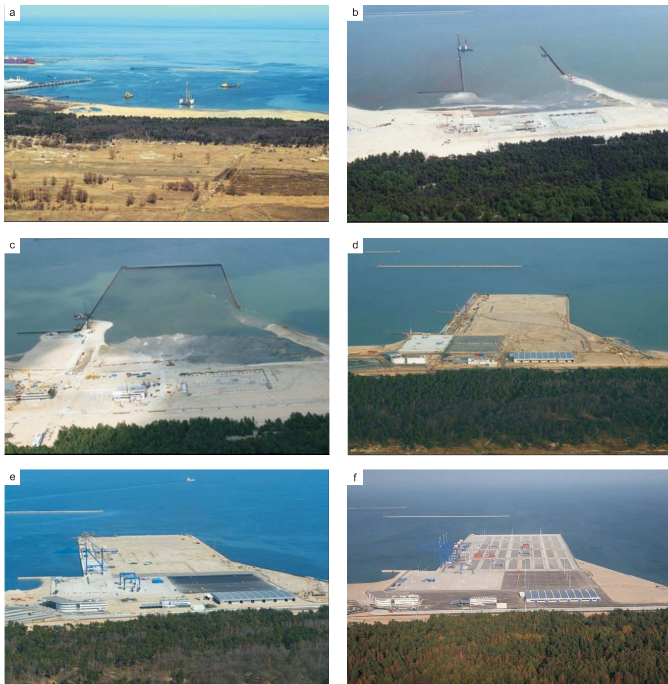
Rys. 10.24. Widok kolejnych etapów budowy pirsu
