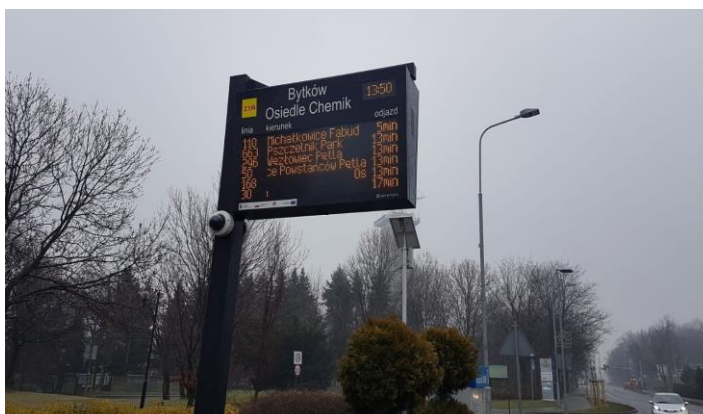
Zdjęcie: Przystanek osobowy z elektroniczną tablicą informacyjną – Siemianowice Śląskie
