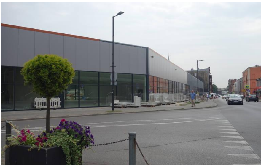
Pawilon handlowo-usługowy przy ul. Śląskiej 15.
