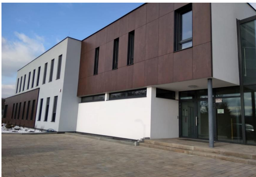
Budynek biurowy przy ul. Budowlanej 17. (Źródło: zdjęcie własne)
