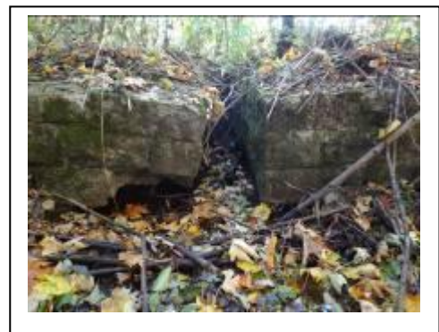
u. przepust kamienny płytowy km 7,513 – częściowo zawalony, na szerokości torowiska rozebrany, zniszczone skrzydła przepustu, do obudowy.
