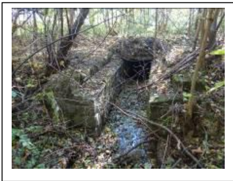
u. przepust kamienny płytowy km 7,513 – częściowo zawalony, na szerokości torowiska rozebrany, zniszczone skrzydła przepustu, do obudowy.
