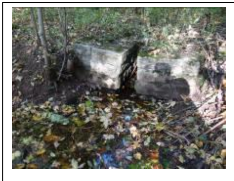
u. przepust kamienny płytowy km 7,513 – częściowo zawalony, na szerokości torowiska rozebrany, zniszczone skrzydła przepustu, do obudowy.
