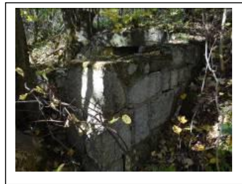
u. przepust kamienny płytowy km 7,513 – częściowo zawalony, na szerokości torowiska rozebrany, zniszczone skrzydła przepustu, do obudowy.
