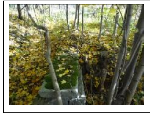
t. przepust kamienny otwarty km 7,330 – częściowo zniszczony i zawalony
