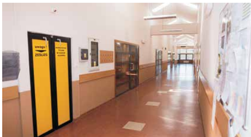
Korytarz po remoncie.
