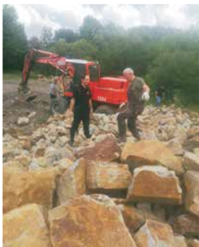
Wybór kamieni pod budowę.
