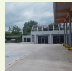
Rys. 27. Punkt Selektywnej Zbiórki Odpadów – EKOPORT przy ul. Arkońskiej w Szczecinie, fot. Andrzej Kus
