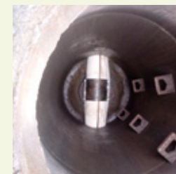
Rys. 16. Renowacja kanałów deszczowych metodą rękawa utwardzanego na miejscu w Bydgoszczy, fot. Jakub Wysocki Miejskie Wodociągi i Kanalizacja w Bydgoszczy Sp. z o.o.
