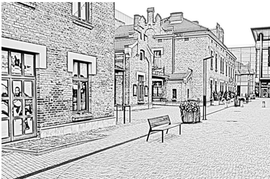
Rys. 4.3.10. Przykład placu przed galerią handlową z prowadzeniem wody opadowej ściekiem odsuniętym od wejść do budynków; na zdjęciu widoczna jest próba ukrycia (kamouflażu) ścieku korytkowego elementami małej architektury
