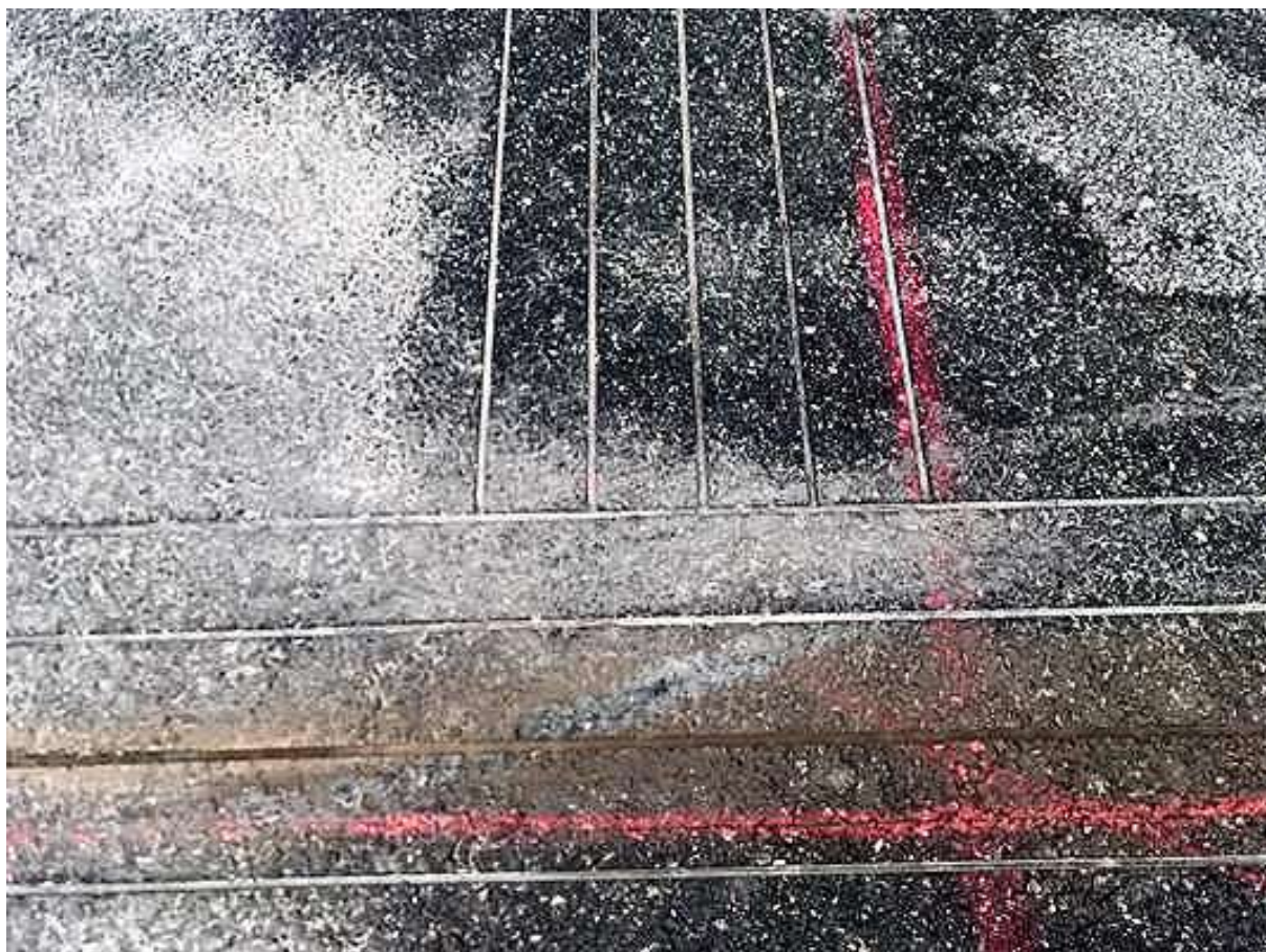
Rys. 12.6.2. Przykład systemu rowkowania warstwy ścieralnej nawierzchni na istniejącej rampie drogowej (fragment) – szczegół (źródło: zdjęcie wykonawcy rowków)
