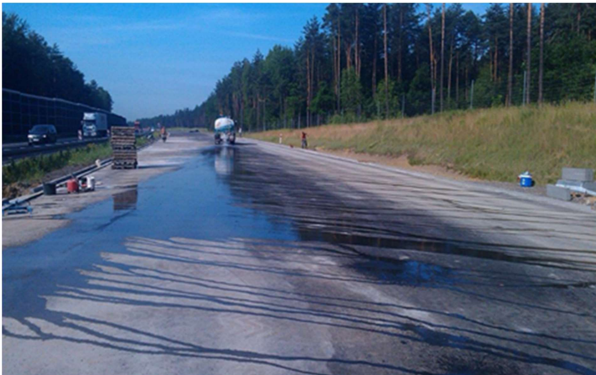
Rys. 4.2.2.3. Przykład rampy drogowej w kształcie koperty – szerokość nawierzchni 10,5 m, pochylenie podłużne 0,7%, koperta o długości 90 m (źródło: GDDKiA)
