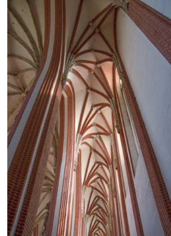
Sklepienie trójpromienne z kościoła Najświętszej Marii Panny na Piasku we Wrocławiu
