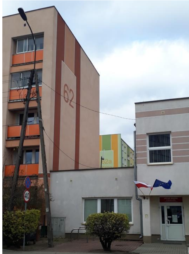
Rys. 3 Miejsce montażu SMS PEM – UM Białystok – widok z poziomu gruntu
