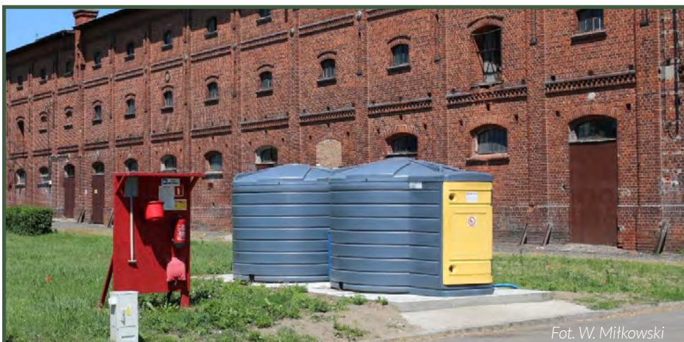
Stacja paliw w zakładzie rolnym wyposażona w nowoczesne, dwuwarstwowe zbiorniki z dystrybutorem oraz punktem przeciwpożarowym.
