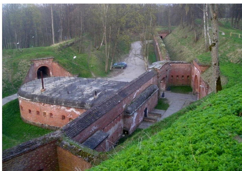
Ryc.13. Kaponiera - element obrony systemu poligonalnego. Feste Boyen w Giżycku, 1844-56. Fot. K. Wielgus
