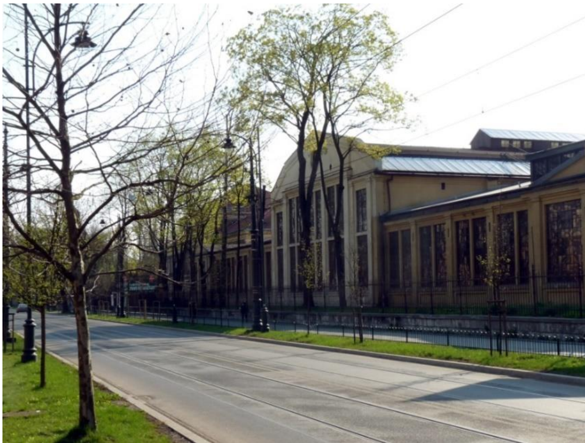
Ryc. 22. Budowla (obiekt) niebojowa w fortyfikacji (system fortowy, Twierdza Kraków), zespół zbrojowni ("Zeughaus") – warsztaty artylerii przy ul. Rakowickiej w Krakowie. Fot. K. Wielgus.
