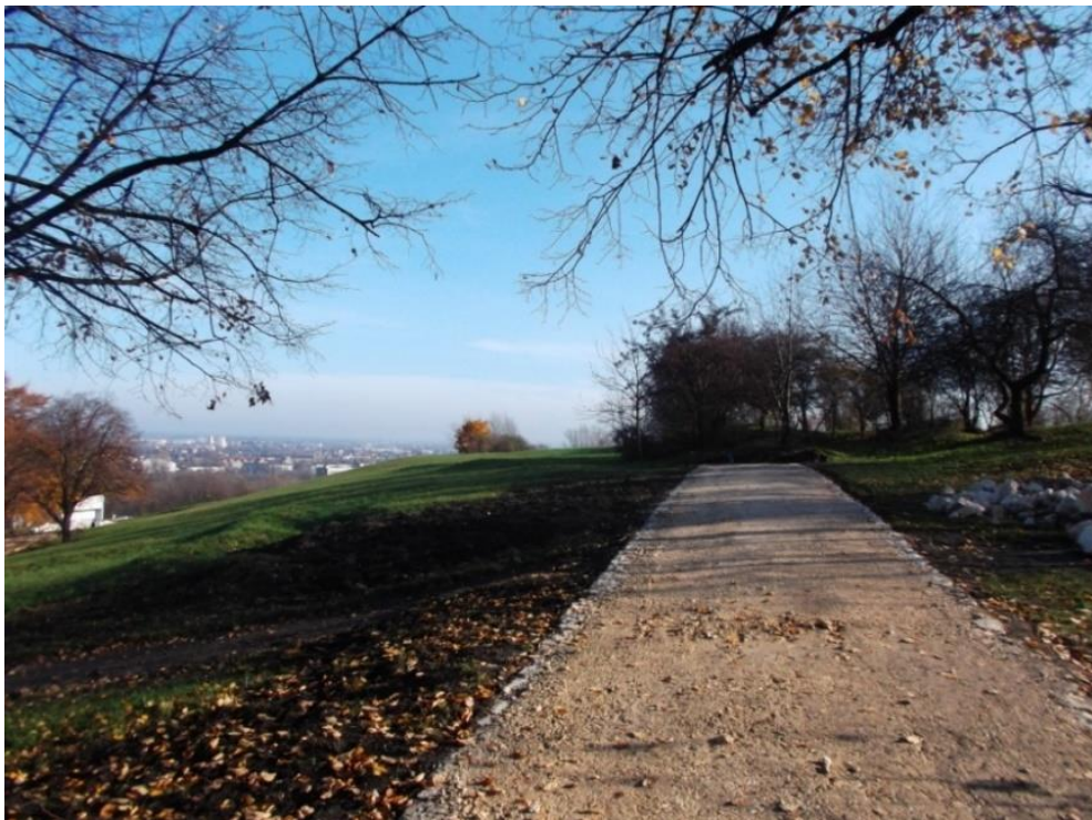
Ryc. 23. Droga forteczna dojazdowa do Fortu 33 "Krakus", odtworzona w 2013 roku zgodnie z historycznymi technologiami Mac Adama i Tressagueta. Fot. K. Wielgus.
