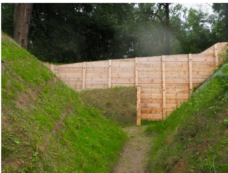
Ryc. 24. Formy ziemne w fortyfikacji. Oryginalne, odrestaurowane ściśle wg historycznych metod i technologii stanowisko piechoty na wale artyleryjskim Fortu 52 "Borek" Twierdzy Kraków (1884-86), rewaloryzacja – 2020 r. Fot. K. Wielgus.
