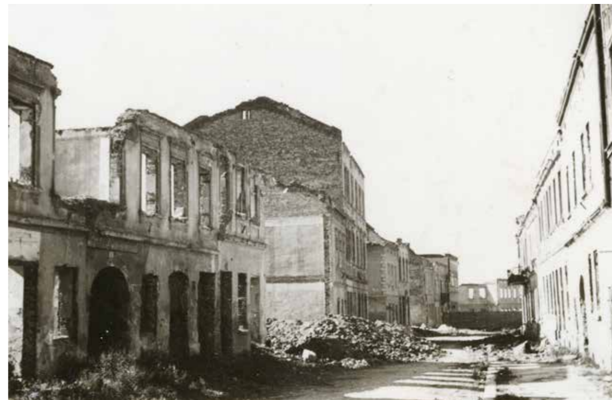
Ilustracja 5.15. Nowy Sącz, widok zrujnowanych domów przy ul. Kazimierza (1945 r.) (Zbiory Muzeum Okręgowego w Nowym Sączu)
