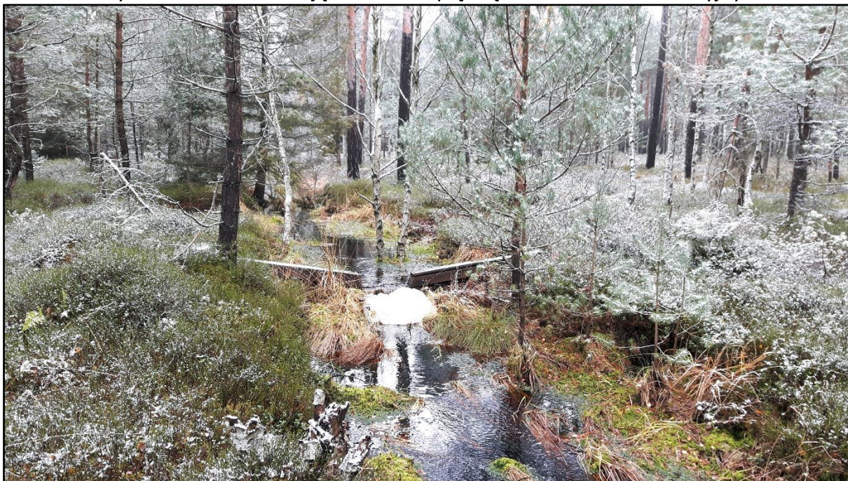
Fot. 8 Rez. „Kurze Grzędy” – zastawki na rowach melioracyjnych spowalniające odpływ wody z torfowiska, oddz. 136d (I-ctwo Bącka Huta)
