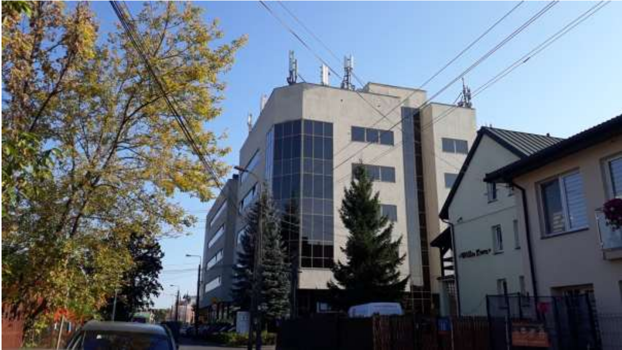
Fot. 1: Widoki anten stacji bazowych ID: WAR2304, zlokalizowanej: ul. Murmańska 25, 04-203 Warszawa oraz ID: 20186 (81385N!), ID: BT16302, zlokalizowanych: ul. Jordanowska 12, 04-203 Warszawa
