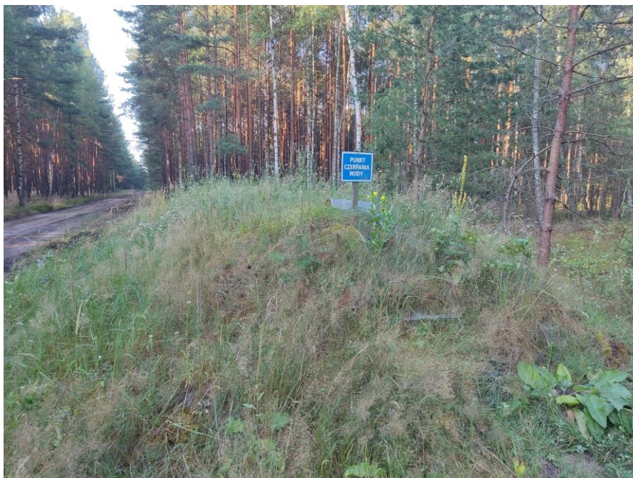
Zdjęcie 2. PODZIEMNY STALOWY ZBIORNIK WODNY W LEŚNICTWIE JAKUBOWO (FOT. A. KOZAK)
