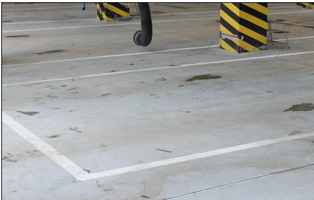
Fot. Posadzka w garażu JRG nr 1.
