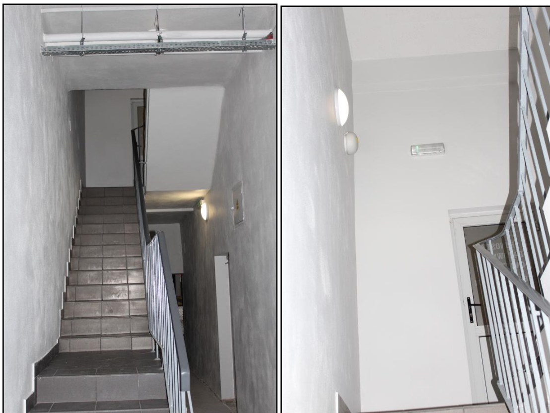
Fot. Remont klatki schodowej i korytarza
