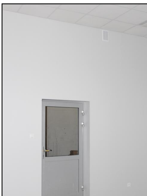
Fot. Remont pomieszczenia przeznaczonego na salę do ćwiczeń.
