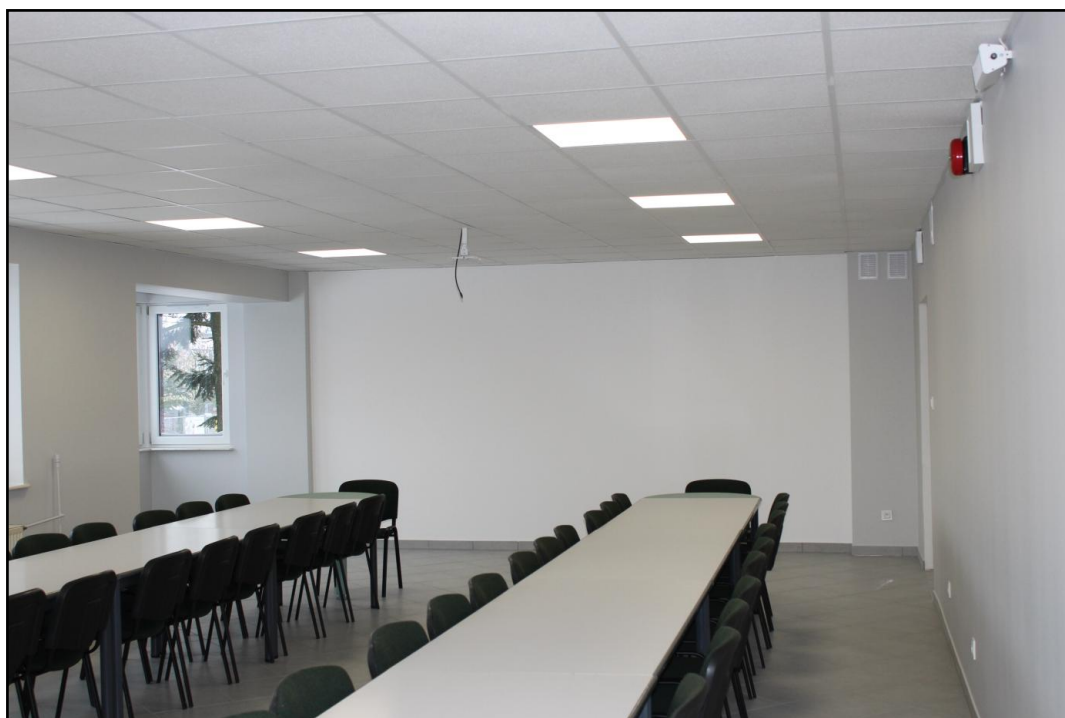
Fot. Remont pomieszczenia przeznaczony na salę szkoleniową
