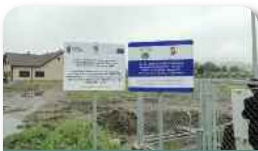
Budowa kanalizacji w gminie Strawczyn. Fot. Adam Bieniaszewski. Archiwum WFOŚiGW w Kielcach.
