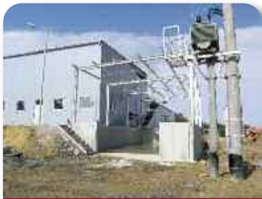
Oczyszczalnia wód kopalnianych (w budowie) na terenie BOT KWB Turów S.A. Fot. Archiwum NFOŚiGW.
