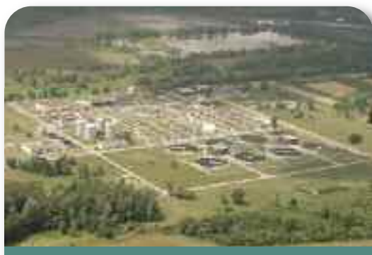
Oczyszczalnia ścieków Kujawy. Fot. Archiwum WFOŚiGW w Krakowie.
