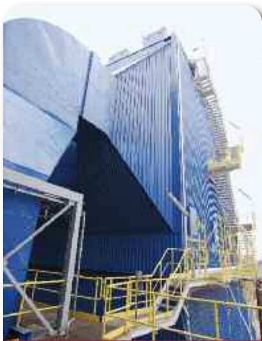
Przebudowa (w trakcie realizacji) kotła parowego w Zakładach Azotowych Puławy S.A. Fot. Archiwum NFOŚiGW.
