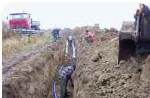
Montaż kanalizacji sanitarnej na obszarze Wielkich Jezior Mazurskich. Fot. Archiwum WFOŚiGW w Olsztynie.
