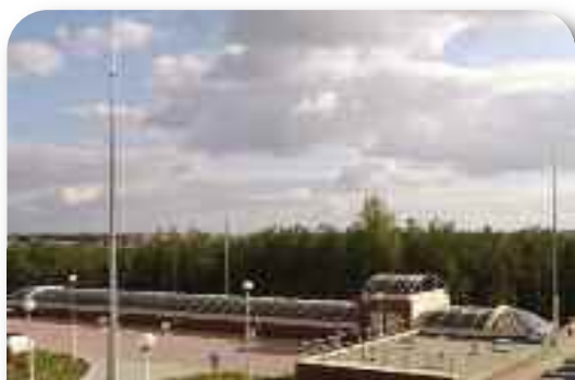
Stacja Uzdatniania Wody Pietrasze – budynek ozonowania pośredniego i filtrów węglowych. Fot. Archiwum NFOŚiGW w Warszawie.
