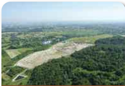
Biogaz na składowisku odpadów komunalnych Barycz. Biogaz jest przetwarzany na energię elektryczną i ciepłą. Fot. Archiwum WFOŚiGW Kraków.
