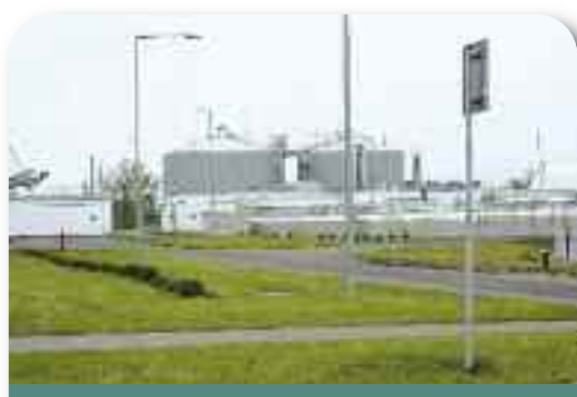
Fragment oczyszczalni Ścieków „Pomorzany”. Fot. Archiwum WFOŚiGW w Szczecinie.
