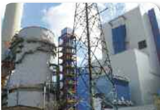
Blok energetyczny na nadkrytyczne parametry pary w elektrowni Pątnów II o mocy 464 MW, pracujący na węglu brunatnym.
