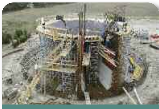
Budowa oczyszczalni w Witwicy. Fot. Archiwum WFOŚiGW w Zielonej Górze.
