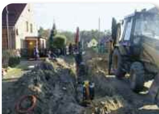
Budowa kanalizacji sanitarnej. Fot. Archiwum WFOŚiGW w Opolu.
