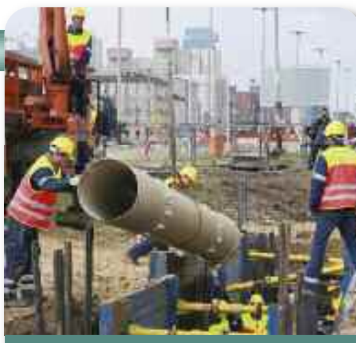
Budowa kanalizacji w Łodzi. Fot. Archiwum WFOŚiGW w Łodzi.
