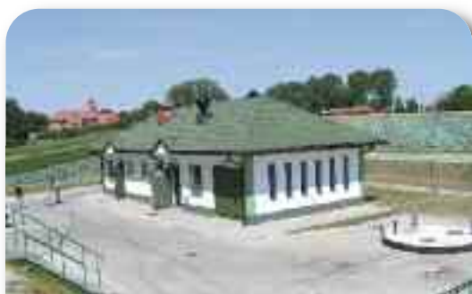
Oczyszczalnia ścieków w miejscowości Żłota. Fot. A. Bieniaszewski.
