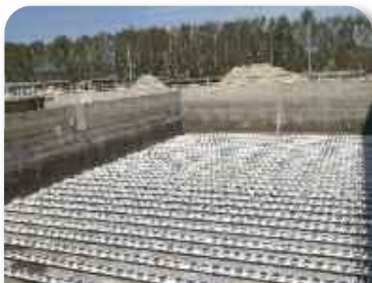
Modernizacja oczyszczalni w Zgierzu. Ruszt napowietrzający zamontowany w reaktorze biologicznym. Fot. Archiwum WFOŚiGW w Łodzi.
