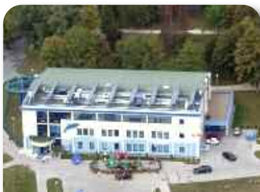
Aquapark „Wodny Świat” w Kudowie Zdroju został wyposażony w kolektory słoneczne o łącznej powierzchni 300 m 2 . Fot. Archiwum WFOŚiGW we Wrocławiu.
