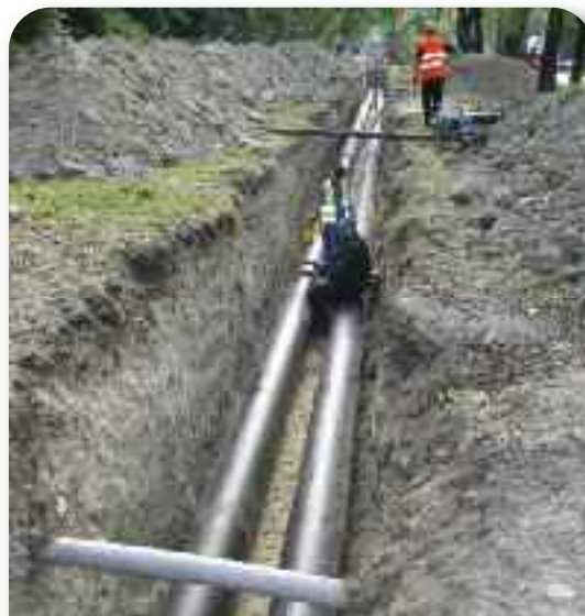
W Lublinie wymieniono sieć ciepłowniczą na sieć wykonaną z rur preizolowanych o łącznej długości ok. 2 km. Fot. Archiwum LPEC Sp. z o.o. w Lublinie.
