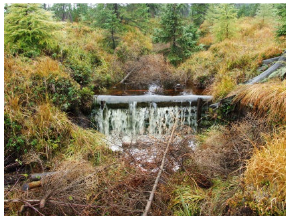
Próg drewniany na rowie odprowadzającym wodę z torfowisk po zboczu oraz rumosz drzewny wrzucany do rowu celem przyspieszenia zarastania – Nadleśnictwo Świeradów. Źródło: Archiwum CKPŚ
