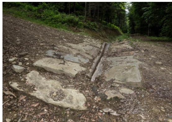
Wodospust odprowadzający wodę z drogi do lasu.
