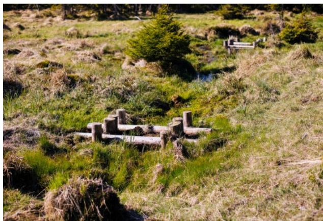
Zarastający rów odwadniający dzięki zastosowaniu przytamoń ziemno-drewnianych – Nadleśnictwo Szklarska Poręba. Źródło: Archiwum CKPŚ
