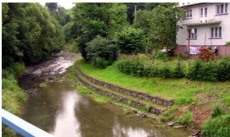
Fot. 3. Zabezpieczenie konstrukcji budowlanych
