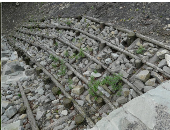
Kratownica ożywiona wierzbą poniżej brodu w Nadleśnictwie Bielsko na gruntach mineralnych szkieletowych podatnych. Źródło: Archiwum CKPŚ.
