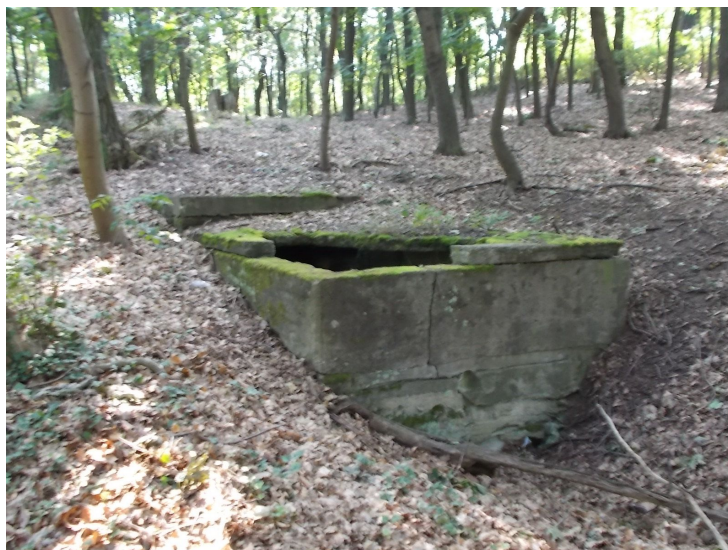
Rysunek 15. Piwnice pałacu na Zamkowej Górze (fot. Marek Byrdy)
