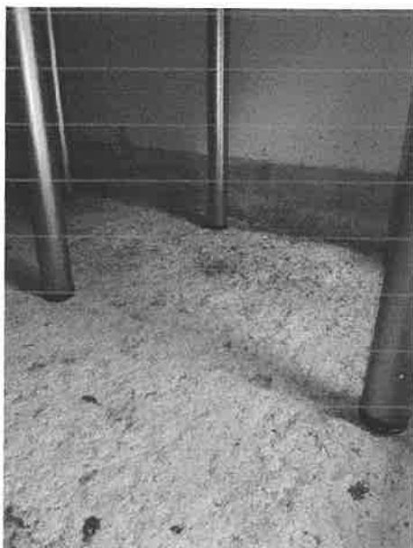
Fot. Nr 3 widok na posadzkę po zdjęciu warstwy desek i legarów
