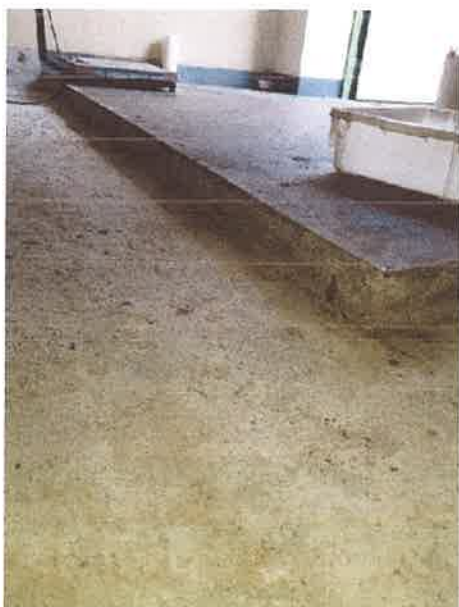
Fot. Nr 1 widok na próg wjazdowy – warstwa posadzki betonowej gr ok. 9 cm.
