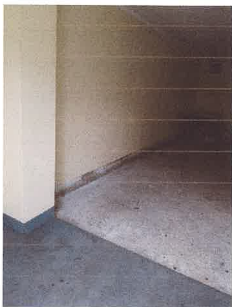
Fot. Nr 1 widok na próg wjazdowy – warstwa posadzki betonowej gr ok. 9 cm.
