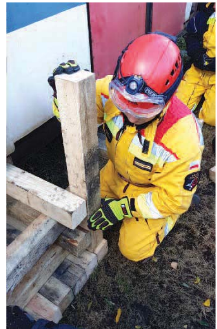
3. Praktyczny sposób na utrzymanie osiowości stosu i odległości poza węzłami. Tu widoczna pierwsza warstwa ułożona w postaci pełnej podstawy
