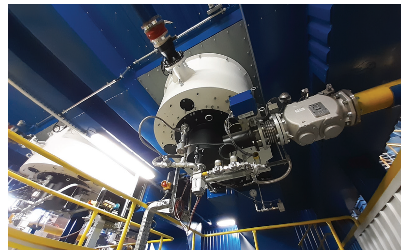
Konwersja kotła węglowego na paliwo gazowe
