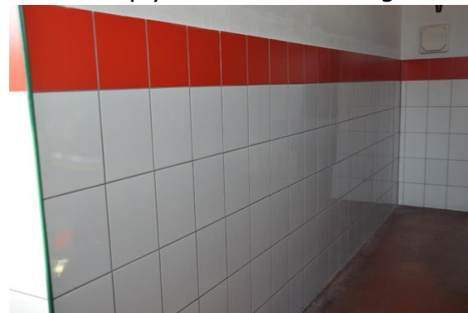
Ułożenie płytek na ścianach w garażu
