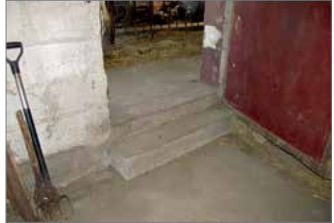
Wady konstrukcyjne budynków i schodów - niezabezpieczone otwory zrzutowe, brak poręczy i barierek
