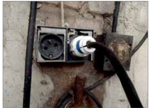
Zły stan techniczny instalacji elektrycznych
