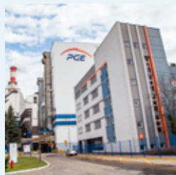
Fig. 19. PGE Energia Ciepła SA Oddział nr 1 w Krakowie, photo by PGE Energia Ciepła SA
