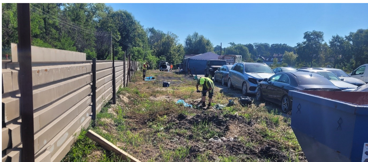
Fot. 2. Widok od strony zachodniej na fragment działki 336/31 obręb Wilczyce, gmina Długołęka, 4.08.2022
