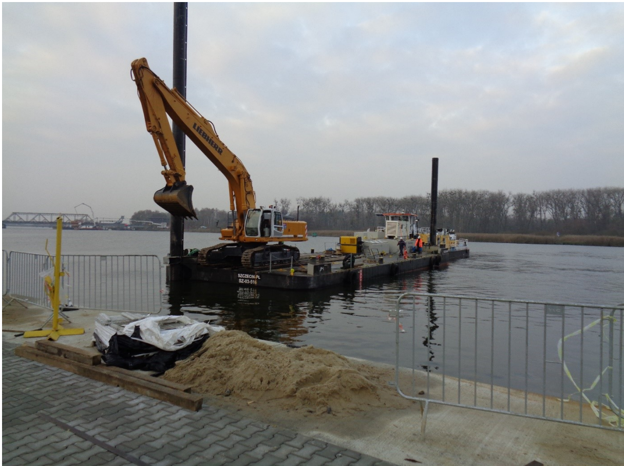
Fot. 10 Prace hydrotechniczne listopad 2022
