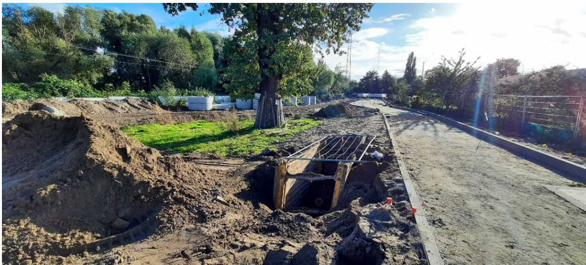
Fot. 6 Teren budowy październik 2022
