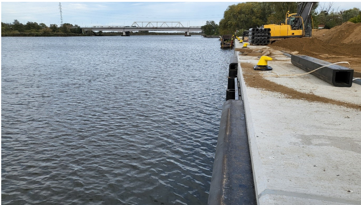
Fot. 9 Wykonane nabrzeże październik 2022
