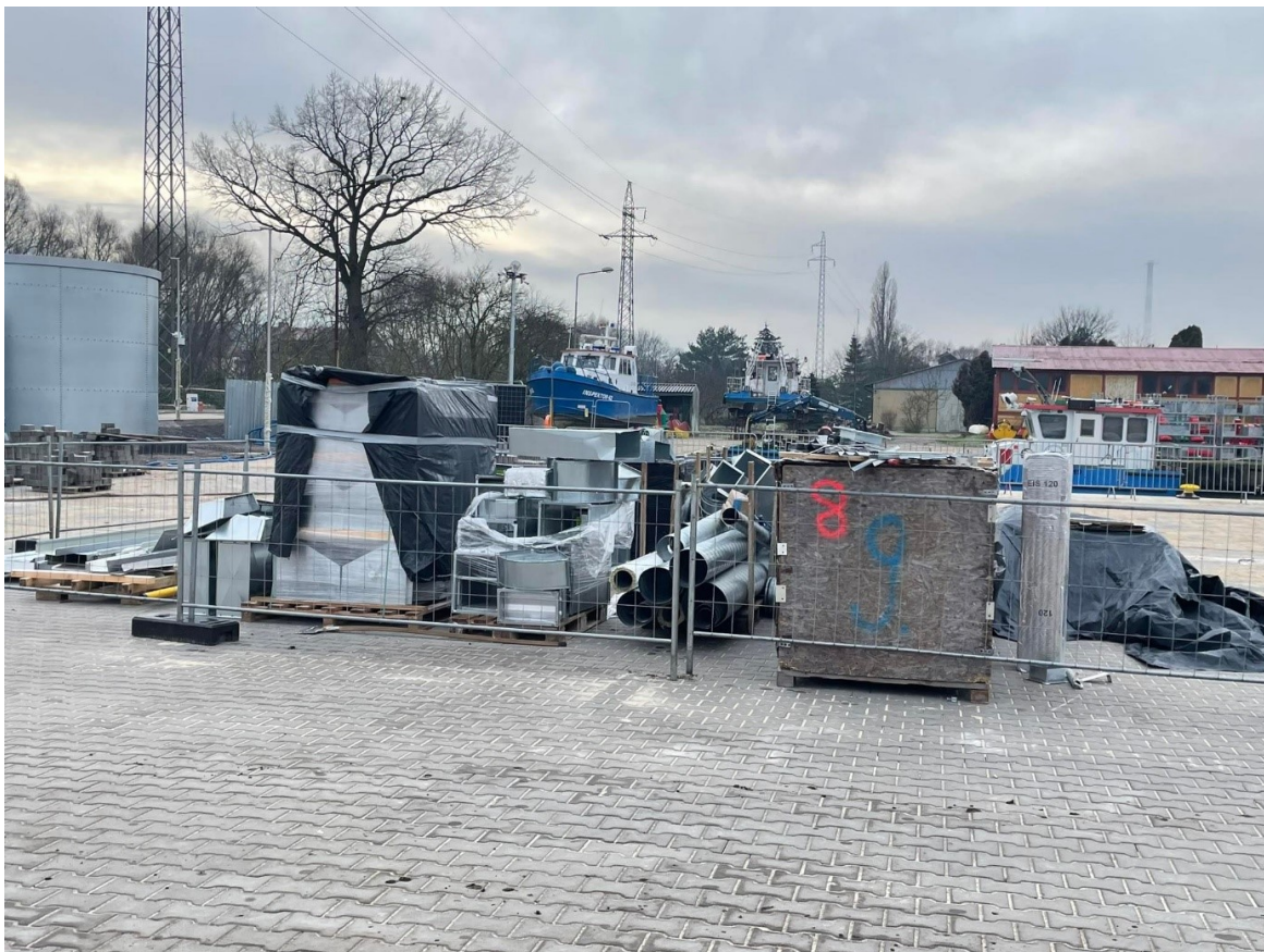
Fot. 8 Wyznaczone miejsce gromadzenia materiałów budowlanych
