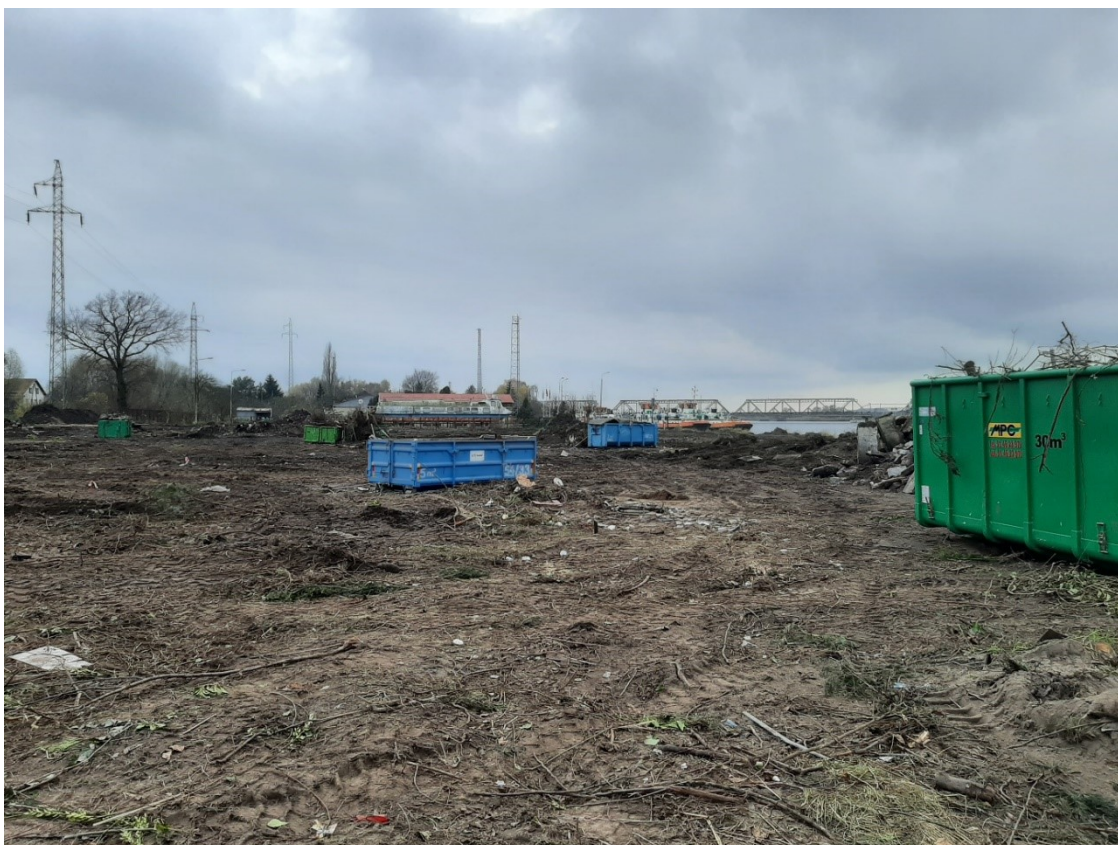
Fot. 4 Prace porządkowe przed przystąpieniem do prac
