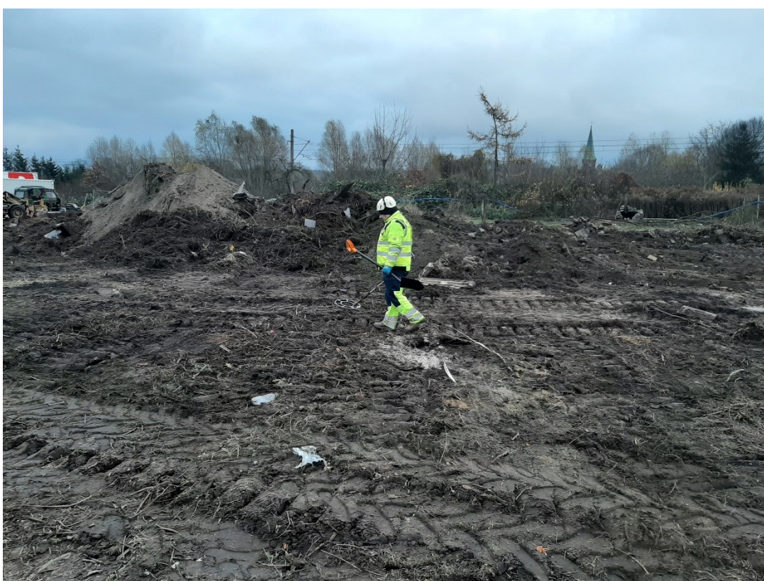
Fot. 3 Rozpoznanie saperskie terenu budowy przed przystąpieniem do prac
