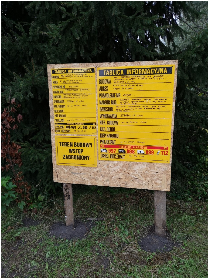
Fot. 1 Oznakowanie terenu budowy
