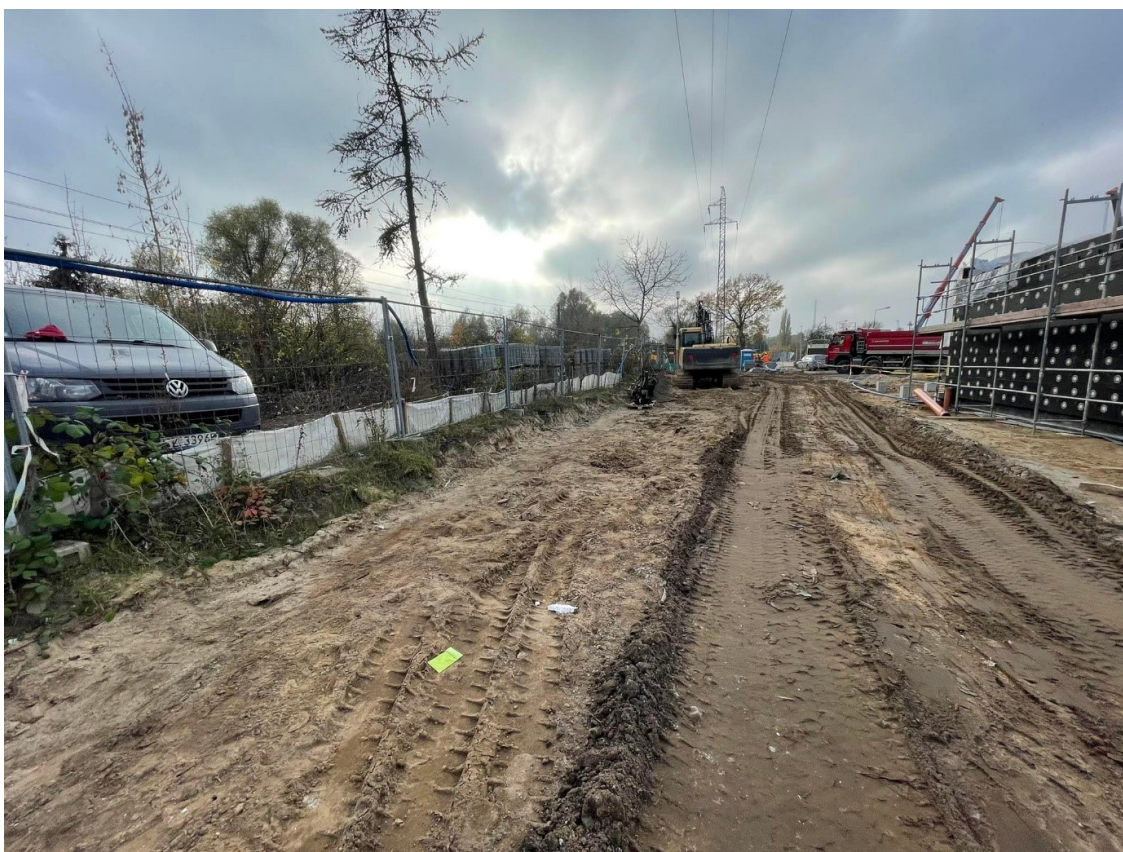
Fot. 7 Ogrózenie terenu budowy wraz z płótkiem herpetologicznym
