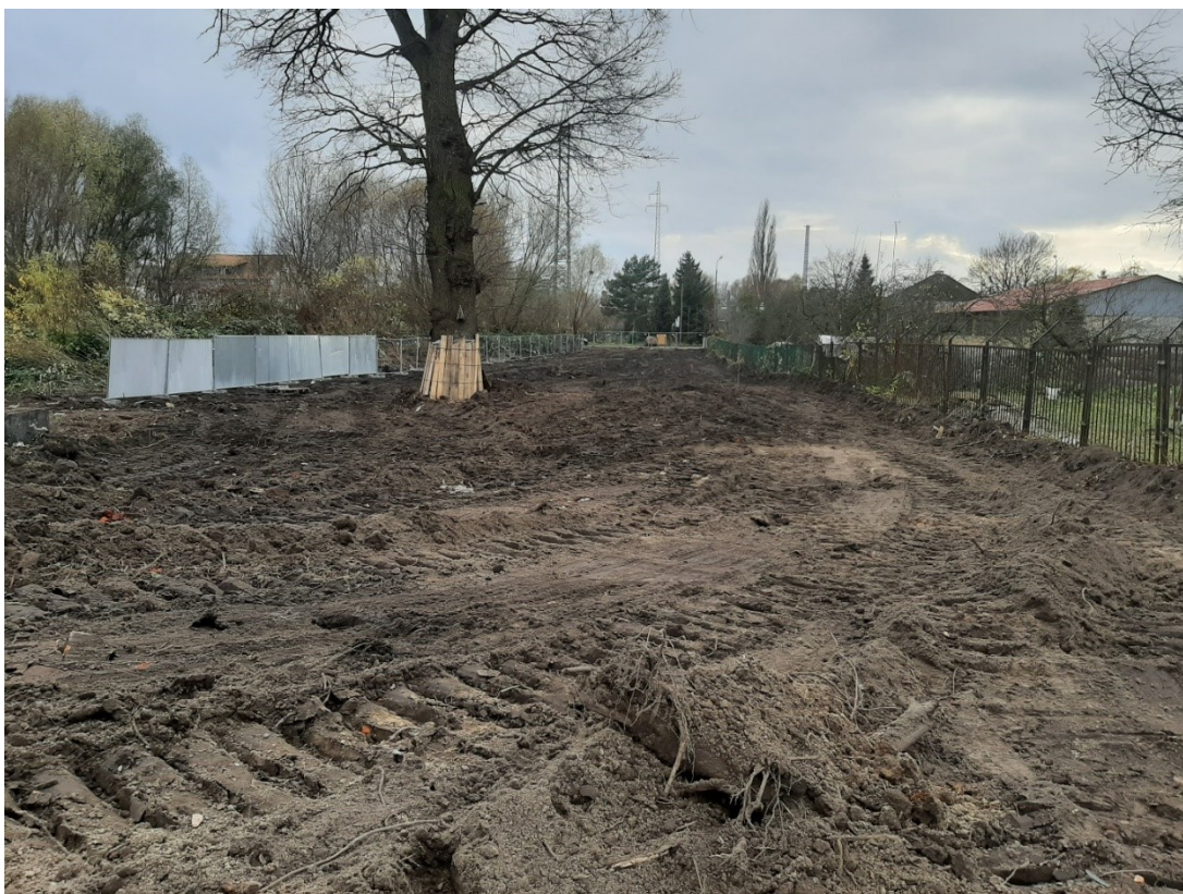
Fot. 2 Zabezpieczenie drzewa nieprzeznaczonego do wycinki
