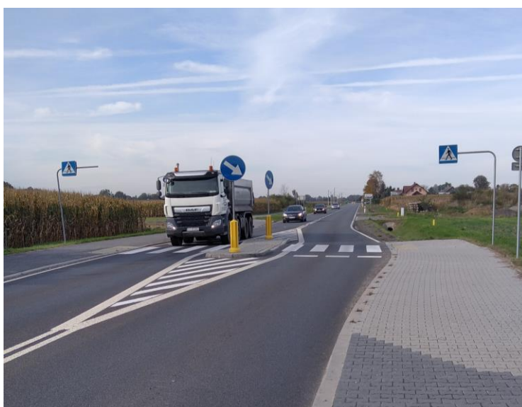
Fot. 11. Studzionka, RB4. Badany odcinek ul. Wodzisławskiej w kierunku skrzyżowania z DK 81.
