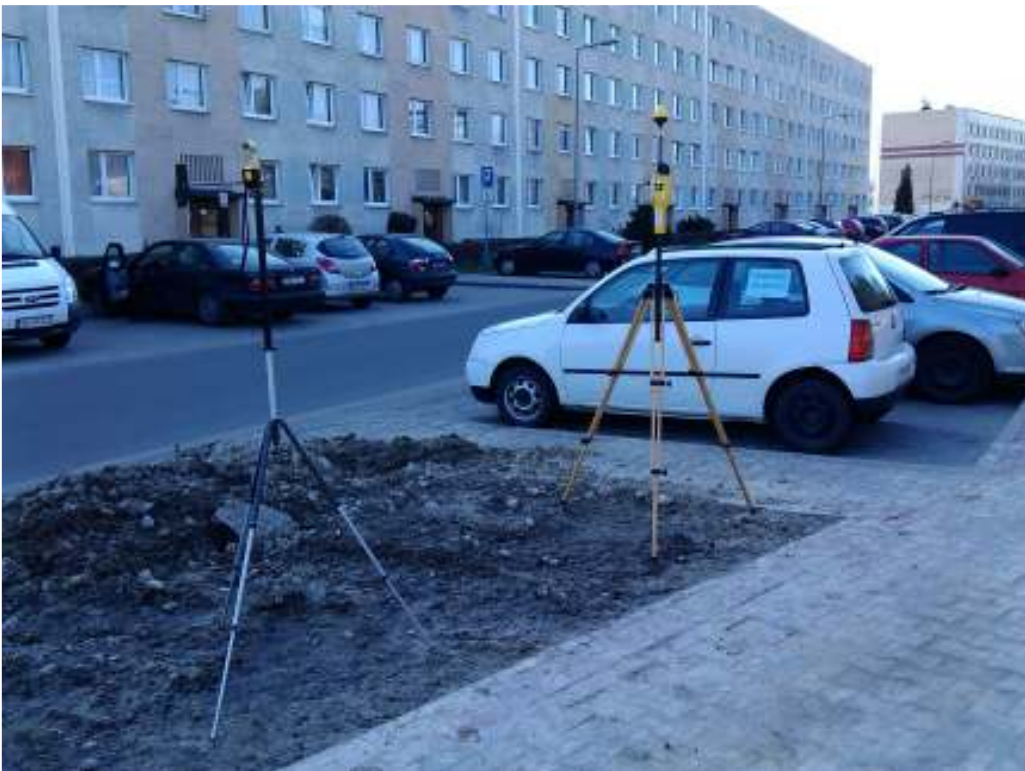
Fot. 2. Rejon badań, widok w kierunku południowym
