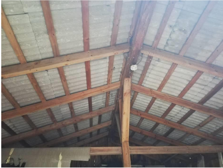
fot. 5 Widok wnętrza
