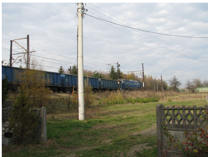
Fot. 5. Borowe, RB2. Linia kolejowa nr 131 w kierunku Kłobucka.
