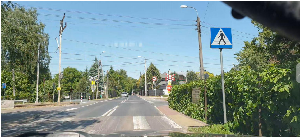
Zdjęcie 14– Widoczność przejazdu z 30 m (źródło: materiał własny PKBWK)
