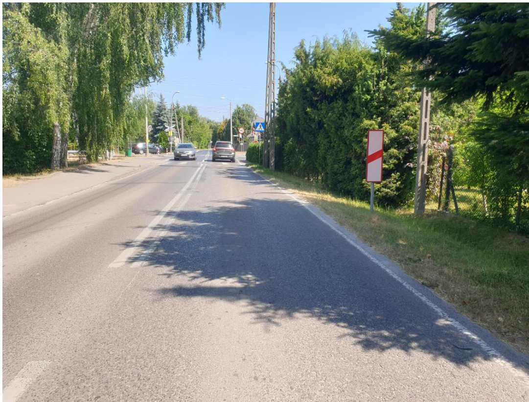
Zdjęcie 12 – Widoczność przejazdu z 60 m (źródło: materiał własny PKBWK)
