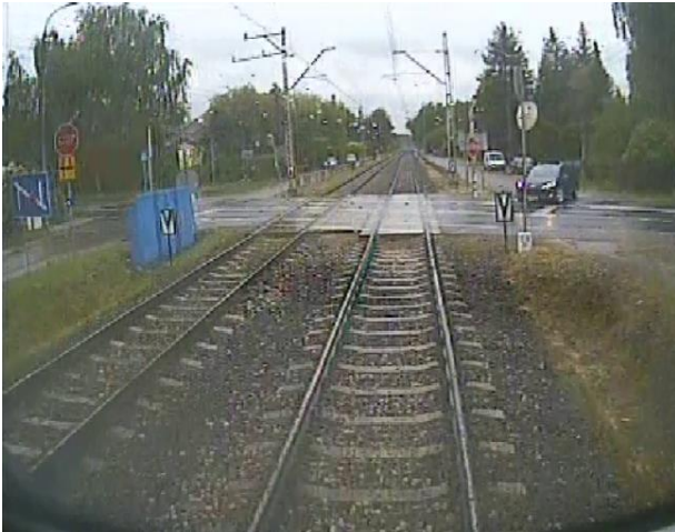
Zdjęcie 6 - Widok przedpola jazdy na ok. 2 s przed wypadkiem zarejestrowany przez kamerę pojazdu kolejowego (źródło: komisja kolejowa)
