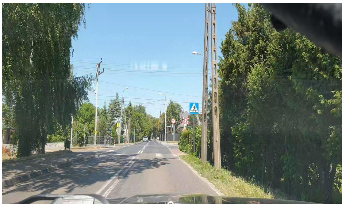
Zdjęcie 13 – Widoczność przejazdu z 40 m (źródło: materiał własny PKBWK)
