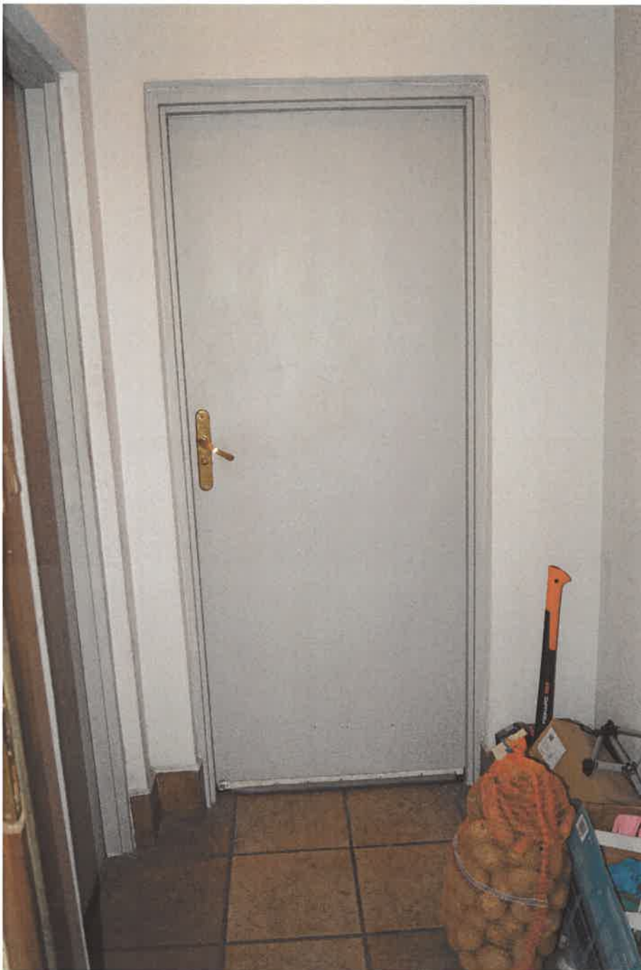
Istniejące drzwi wewnętrzne
