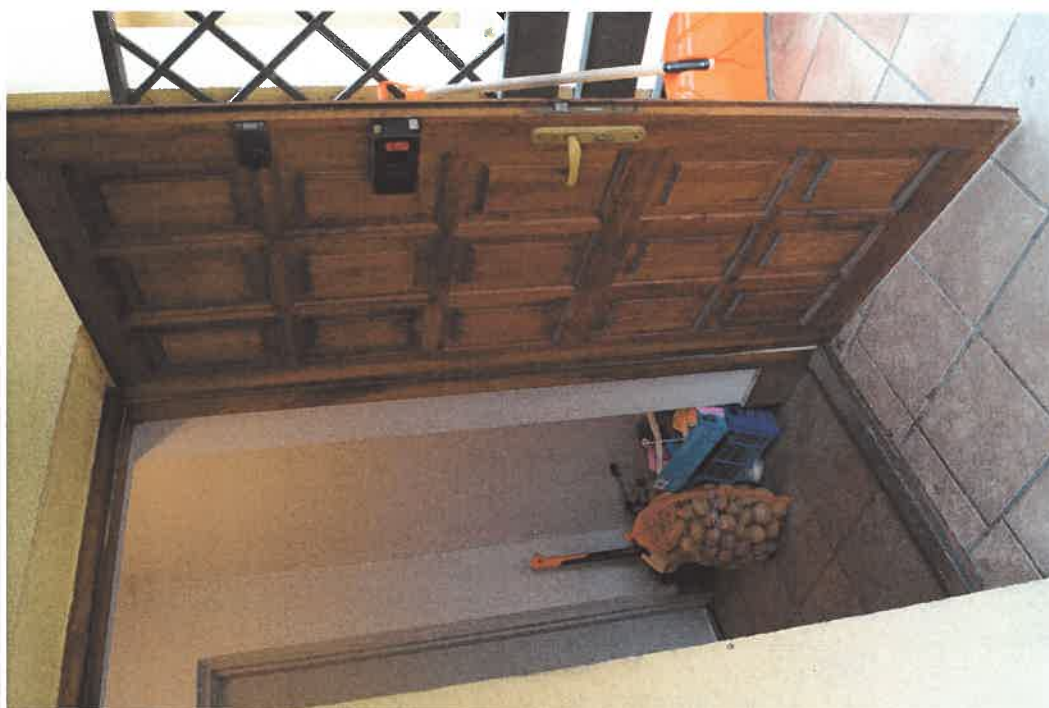
Istniejące drzwi zewnętrzne
