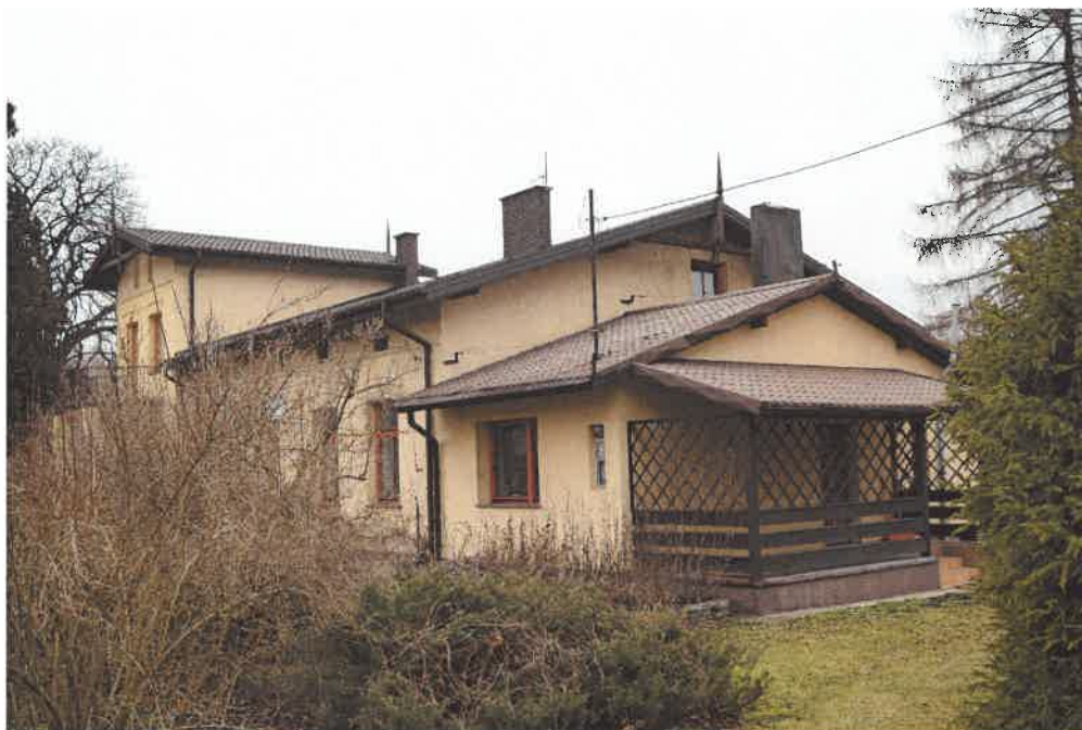
Zadanie obejmuje malowanie całej podsufitki – również ponad dachami
