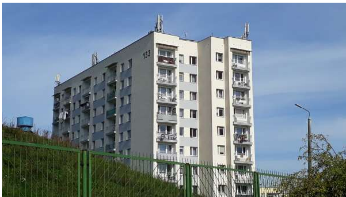
Fot. 1: Widoki anten stacji bazowych ID: KIE1031 oraz ID: BT14147, zlokalizowanych: ul. Jana Nowaka-Jeziorańskiego 133, 25-432 Kielce
