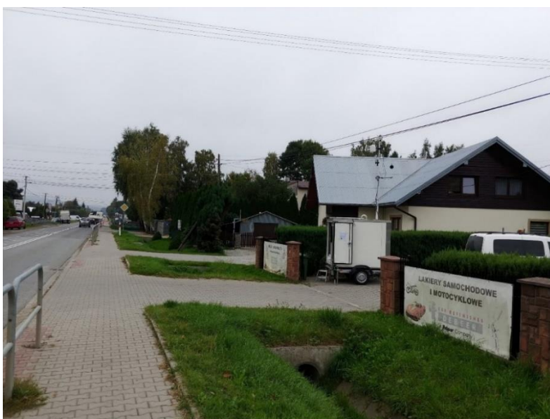
Fot. 4.2. Chełmiec, ul. Limanowska – fragment mapowanego odcinka drogi DK 28
