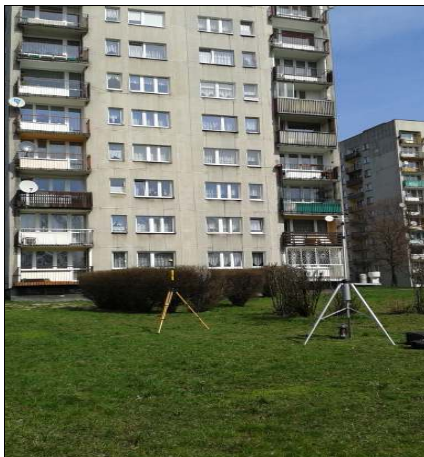
Fot. 2. Rejon badań, widok w kierunku północno-wschodnim
