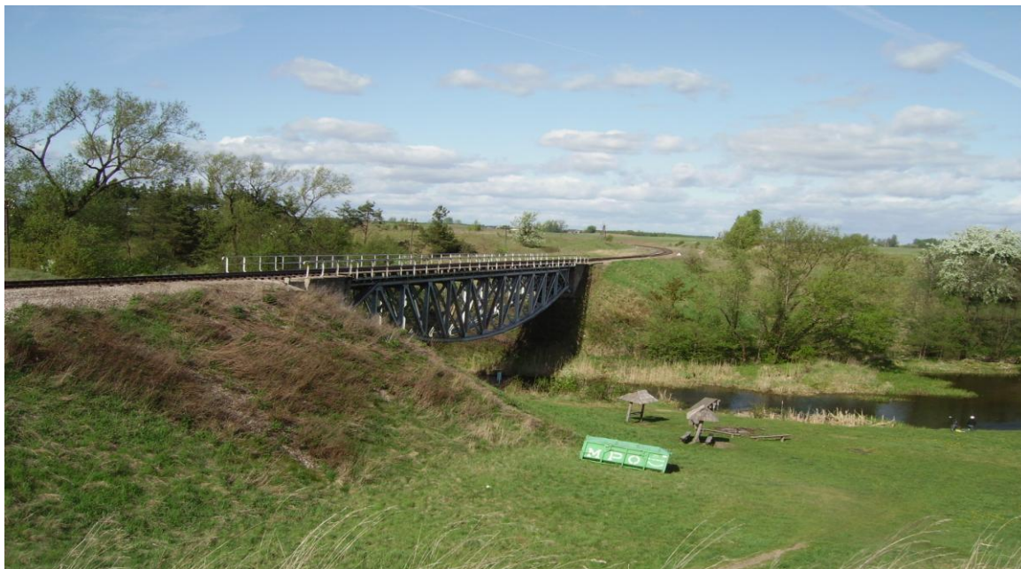
Most kolejowy w Raczkach (Fot. T. Hryciuk).
