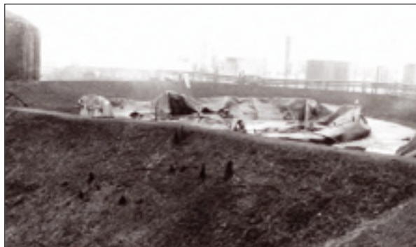
Skutki pożaru w Rafinerii Czechowice – Dziedzice 1971 r.
