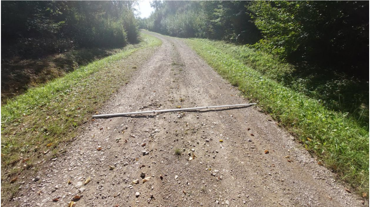
Zdjęcie 3. Zdjęcie poglądowe nr 2 - rozmyta nawierzchnia jezdni
