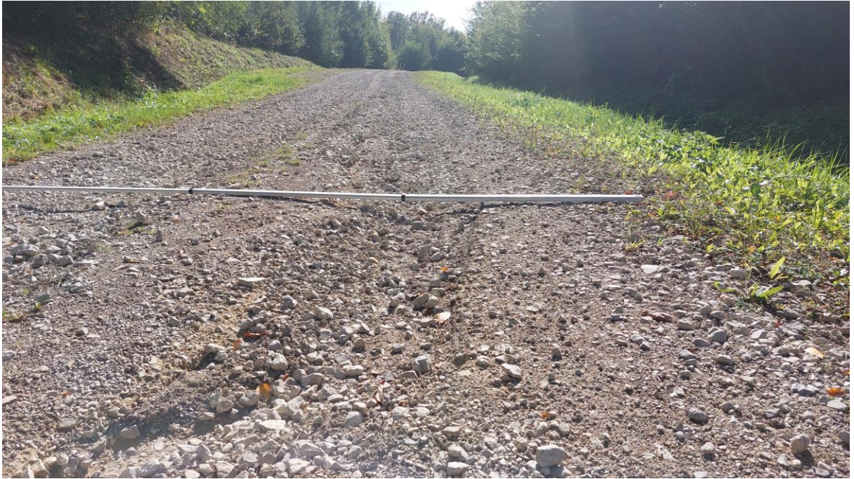
Zdjęcie 5. Zdjęcie poglądowe nr 3 - rozmyta nawierzchnia jezdni
