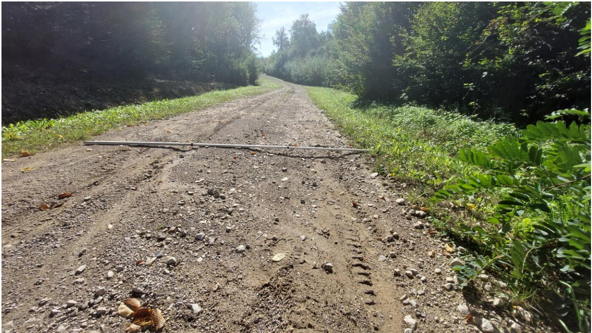
Zdjęcie 1. Zdjęcie poglądowe nr 1 - rozmyta nawierzchnia jezdni
