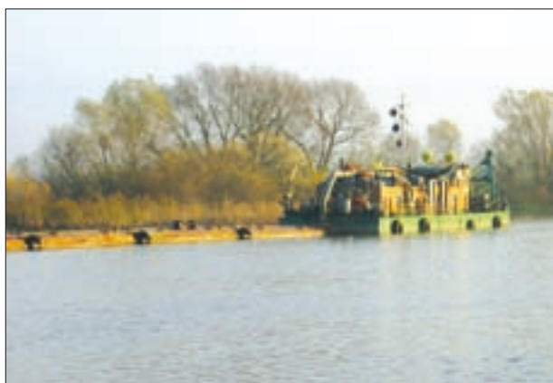
Fot. 28, 29. Roboty odmuleniowe w ujściu rzeki Wąskiej do jeziora Drużno – widoczne refulery oraz rurociąg transportujący (Zdjęcia z archiwum RZGW w Gdańsku)
