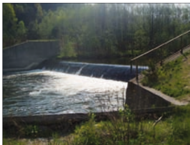
Fot. 6. Widok na jaz od dolnej wody, przed rozpoczęciem inwestycji
