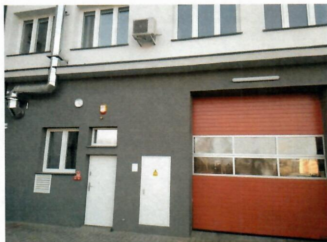
Rysunek 30 Termomodernizacja budynku komendy
