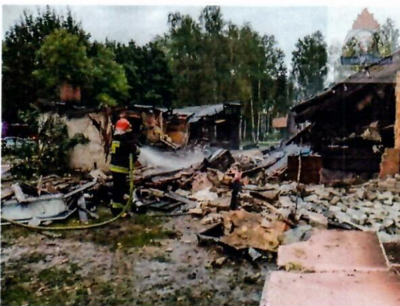
Rysunek 41 Pożar budynku w Joachimowie Mogiatach
