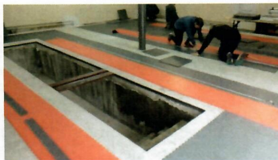
Rysunek 31 Remont pomieszczeń garażu OSP Bolimów
