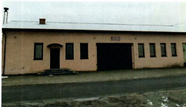
Rysunek 34 Wyremontowany dach OSP Skaczyktody
