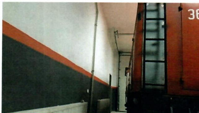
Rysunek 37 Remont pomieszczeń garażu OSP Wola Drzewiecka
