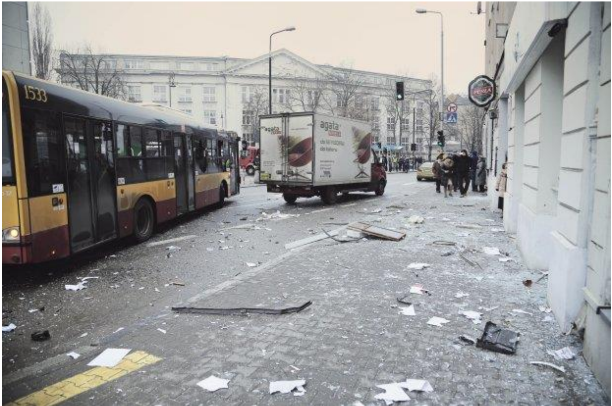
(zniszczenia po wybuchu gazu przy ul. Noakowskiego – fot. warszawa.wyborcza.pl)
