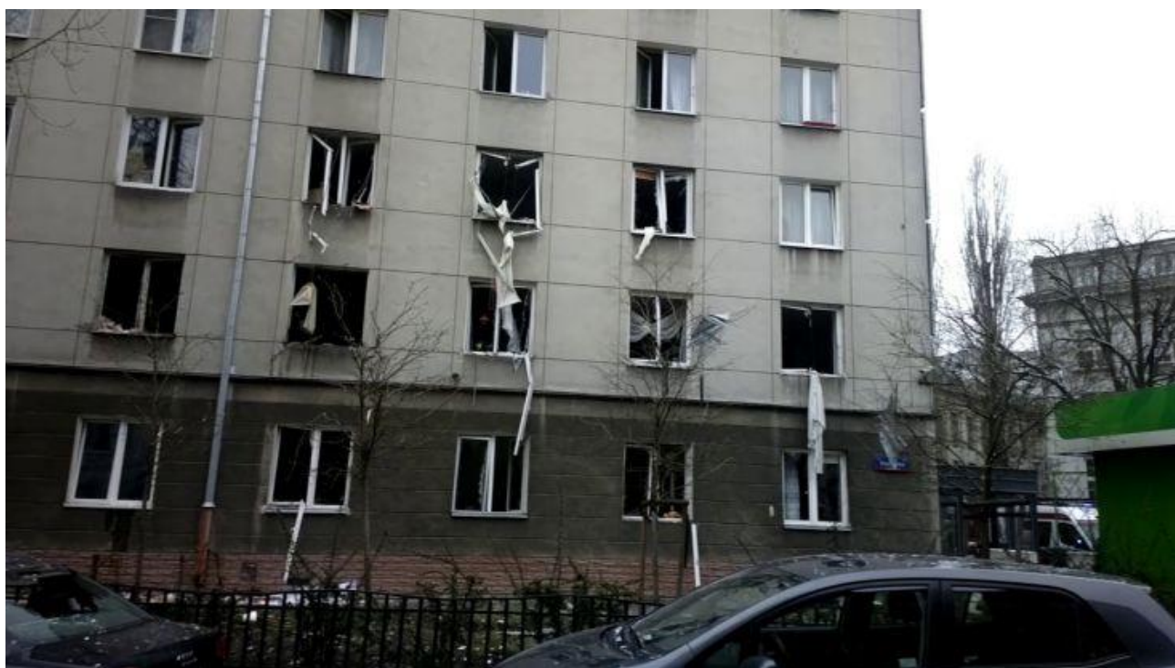
(zniszczenia budynku po wybuchu gazu przy ul. Noakowskiego – fot. warszawa.tvp.pl)
