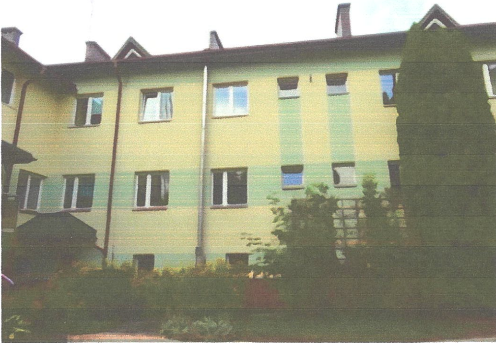
Widok budynku - fragment elewacji południowej
