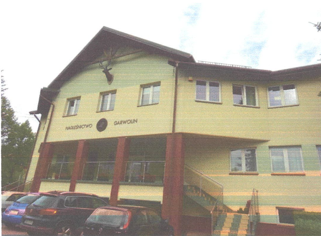
Widok budynku - fragment elewacji zachodniej
