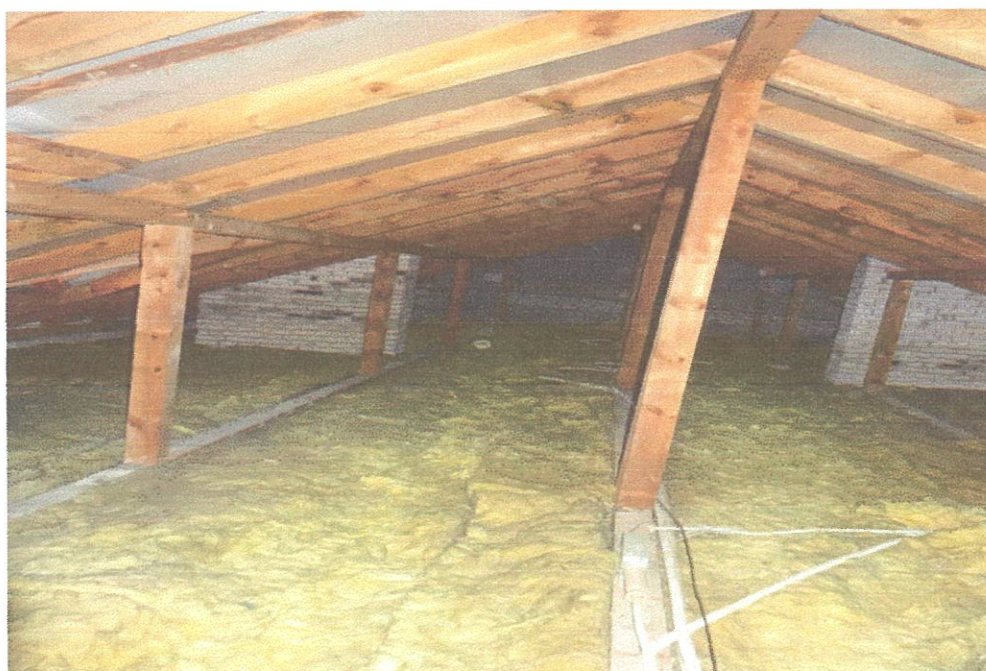
Istniejące docieplenie stropu poddasza
