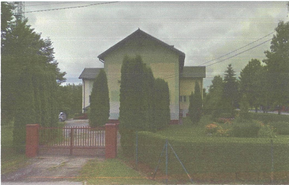
Widok budynku od strony wschodniej
