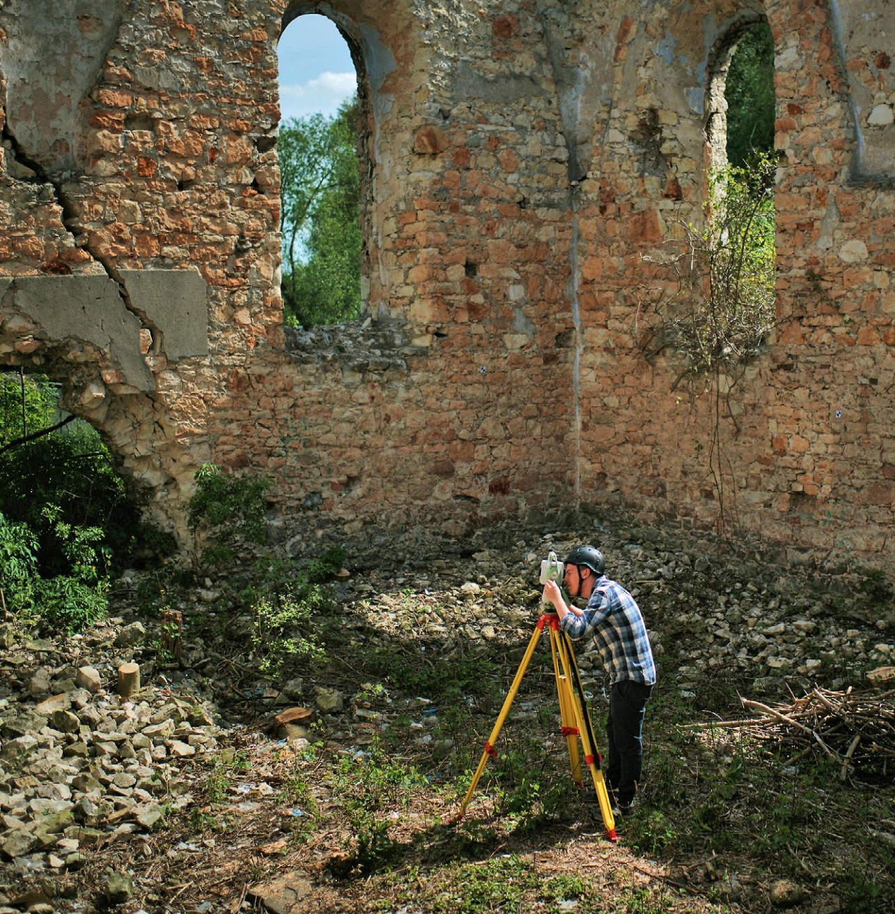
1 Pomiar tachimetryczny ruin synagogi w Tarłowie (fot. K. Czajkowski)
