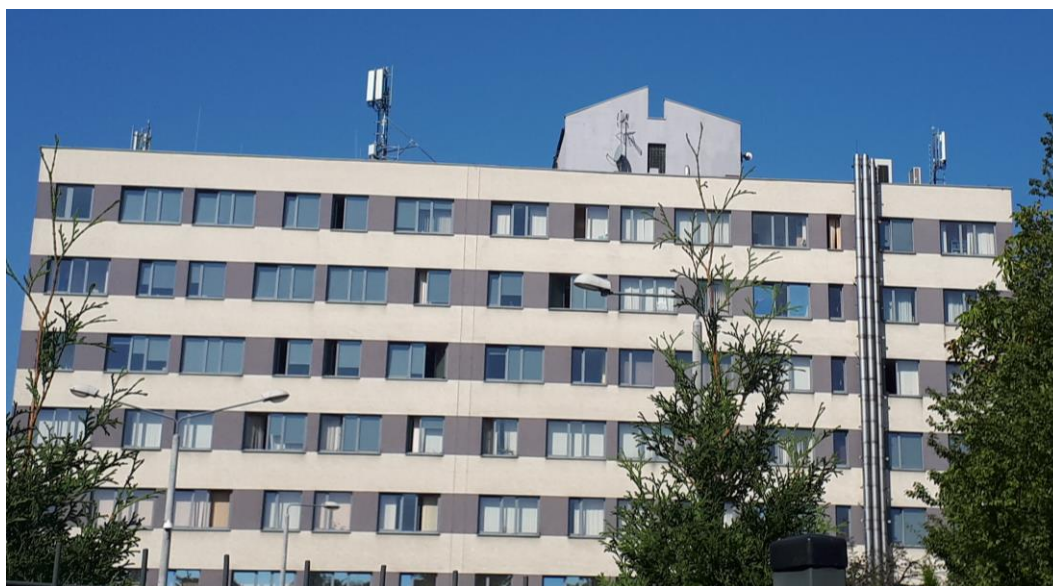
Fot. 1: Widok anten stacji bazowej ID: 2093 (32344), zlokalizowanej pod adresem: ul. Świętego Huberta 11, 40-542 Katowice
