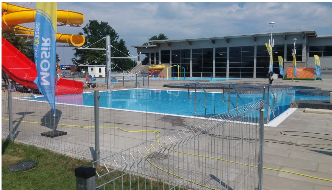
foto: Budowa dwóch basenów odkrytych przy ul. A. Mickiewicza w Ostrowcu Świętokrzyskim (źródło: fotografia własna)
