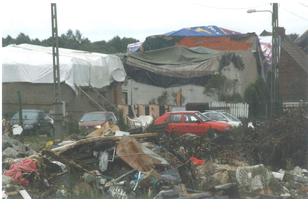
Zniszczenia spowodowane przejściem trąb powietrznych w sierpniu 2008 r. przez wieś Kalina w woj. śląskim
