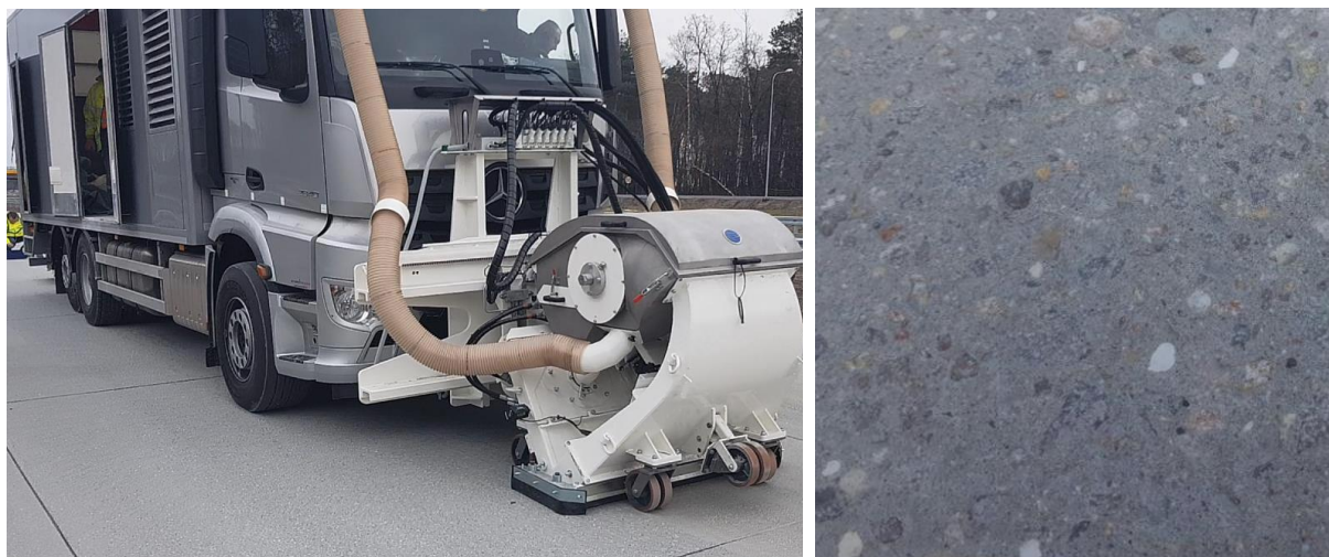
Rys. 5.11.1. Technologia śrutowania nawierzchni
