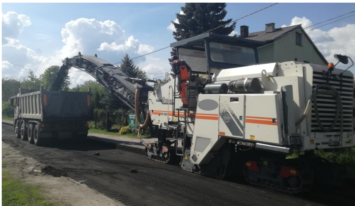
Rys. 4.6.2.1. Przykład frezowania nawierzchni na całej powierzchni
