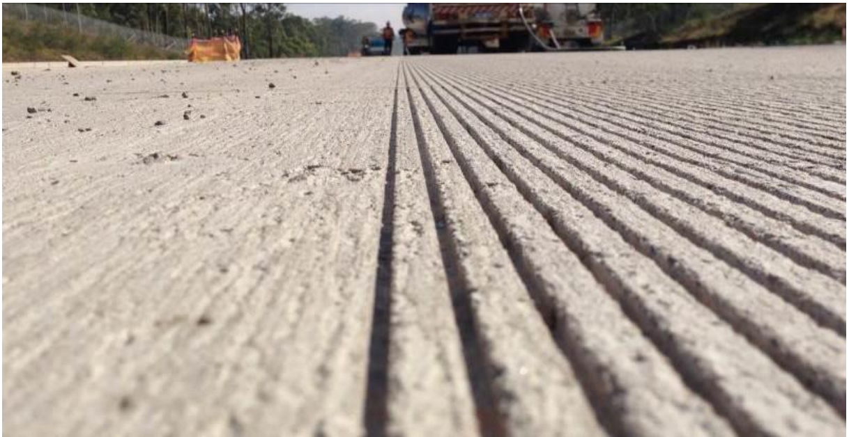
Rys. 5.3.4. Widok nawierzchni po rowkowaniu (Grooving)
