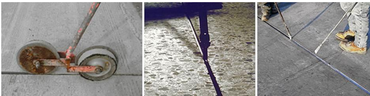
Rys. 5.9.1. Przykład zabiegów dotyczących wymiany wypełnień w szczelinach
