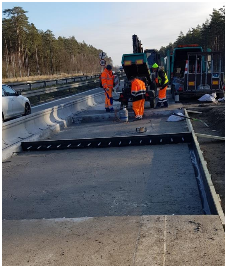
Rys. 5.5.2. Wymiana płyt na mokro
