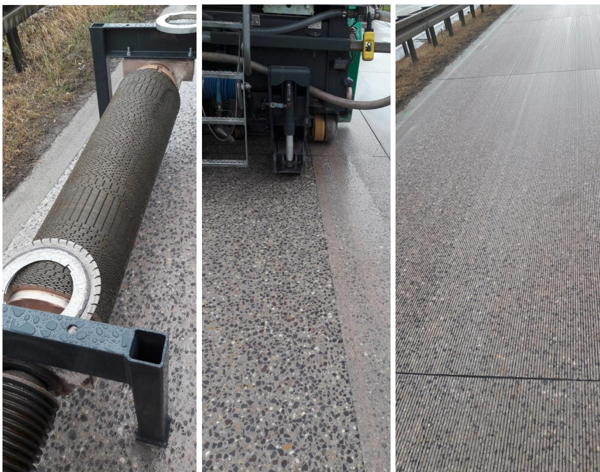
Rys. 5.2.3. Wał roboczy oraz sposób realizacji zabiegu Diamond grinding na nawierzchni
