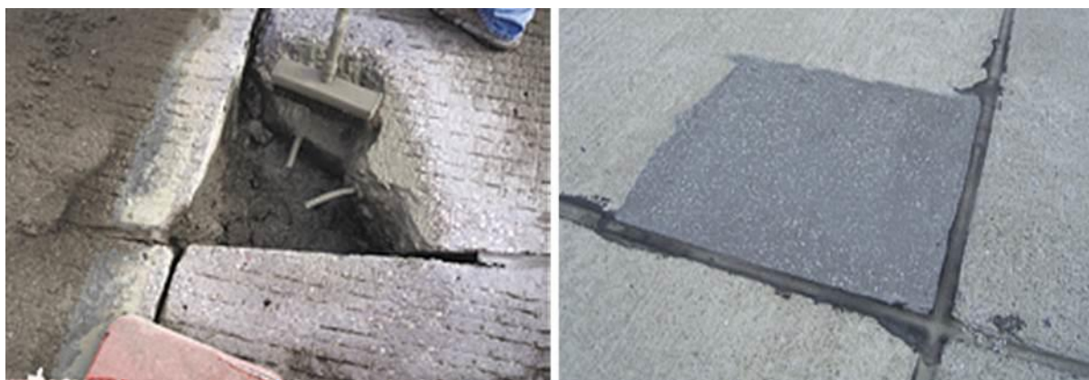
Rys. 5.8.2.1. Przykład wymiany fragmentu płyty przy narożu
