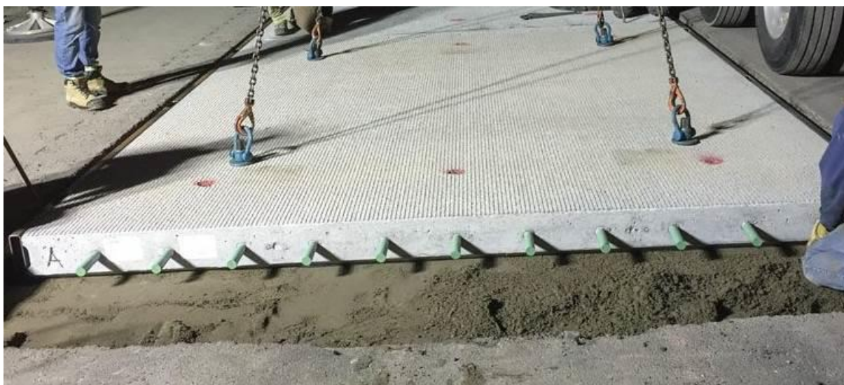
Rys. 5.5.1. Zabieg wymiany płyt na prefabrykowane
