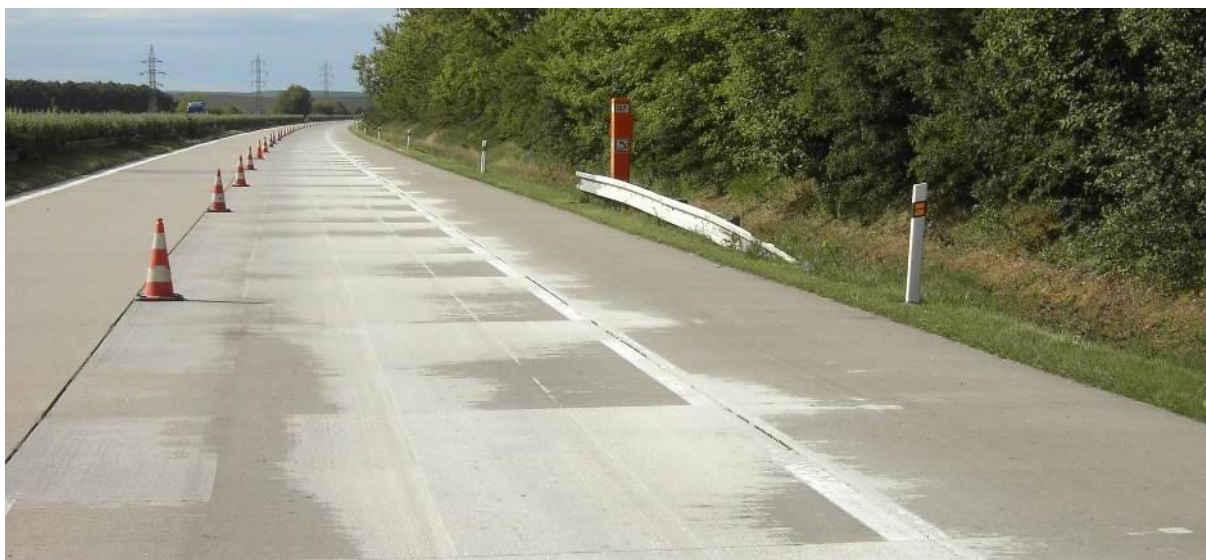
Rys. 5.2.2. Widok nawierzchni po frezowaniu ( Diamond grinding )
