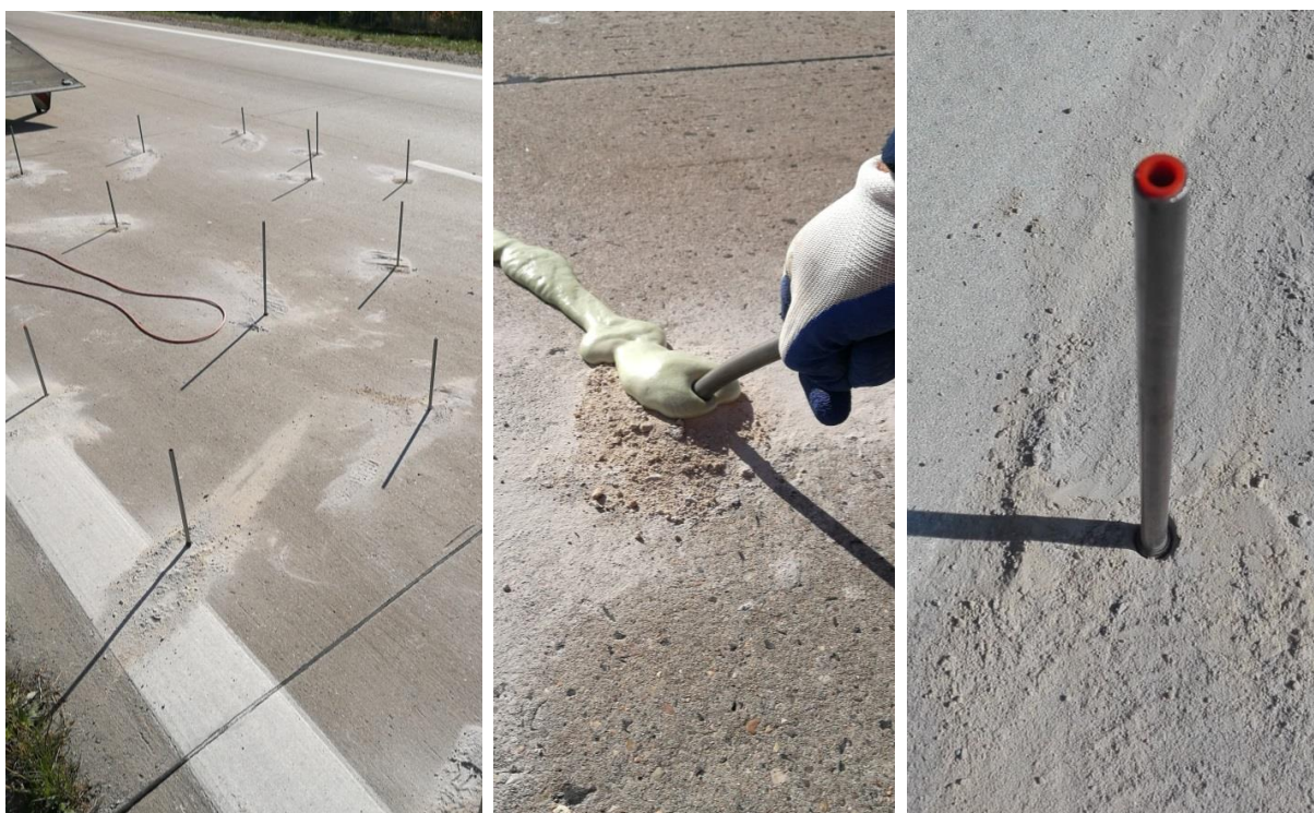
Rys. 5.7.1. Technologia iniekcji za pomocą geopolimerów na nawierzchni
