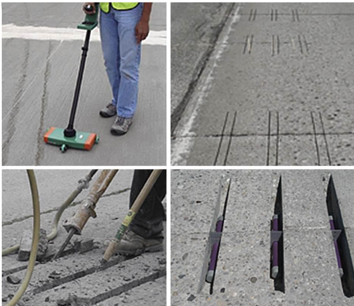
Rys. 5.6.1. Zabieg wymiany dybli
